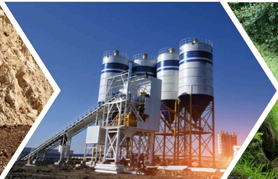
2022-24 Installations de chantier et de stockage des matériaux, pistes de chantier
