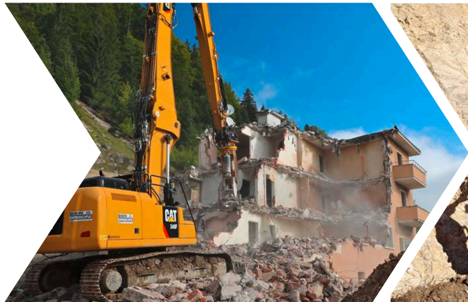
2021-2022 Déconstruction des bâtiments au Col-des-Roches
