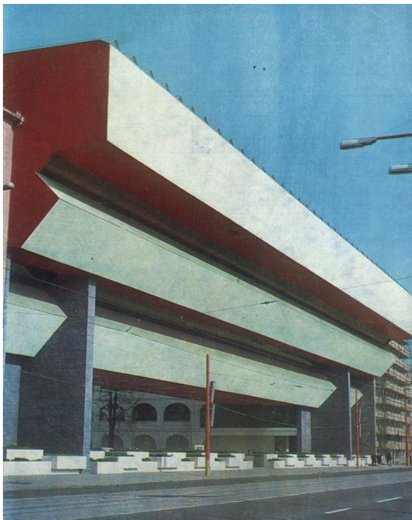
Obrázok 9 Pohľad na dokončené premostenie, 1978, zdroj: archív ateliéru BKPŠ
