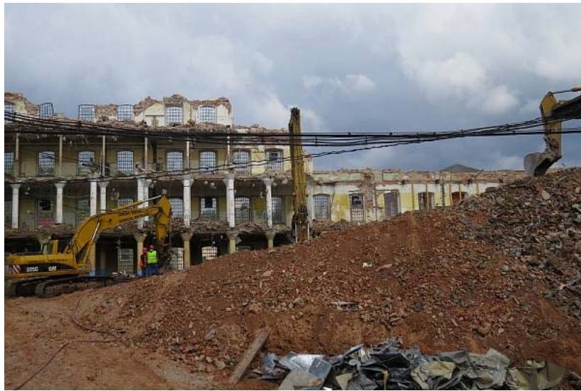
Demolice Slezanu- přádelna
