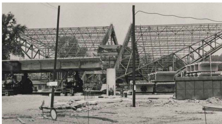
Výstavba víceúčelové sportovní haly
