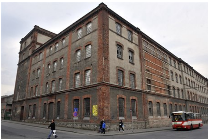
Původní stav Slezanu- přádelna
