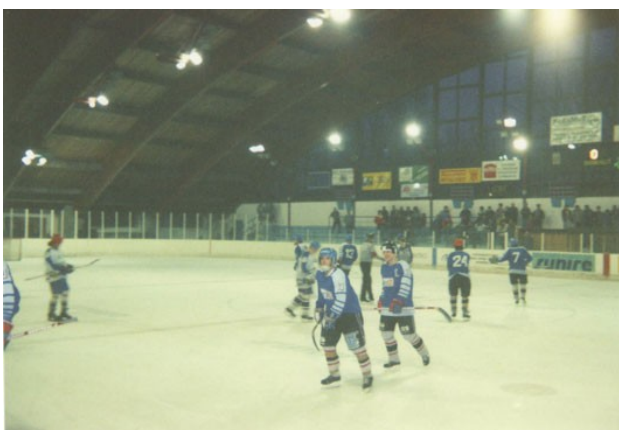
Obrázok 12: Zastrešenie zimného štadiónu Strakonice -v pozdĺžnom smere lepenými drevenými oblúkovými väznikmi (1986)
