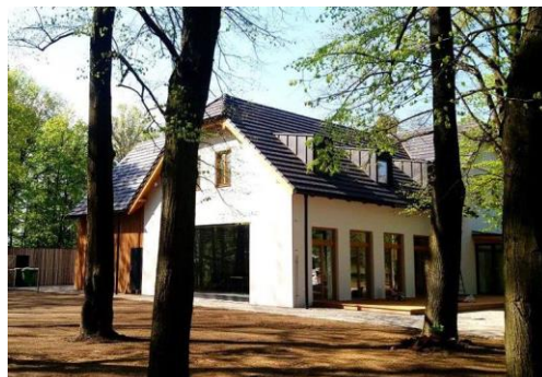
Restaurace Rekovice, rekonstrukce K.Marva, Horečky
