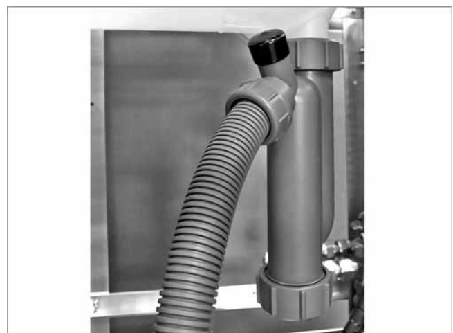
Abb. 15: Siphon mit Kondensatschlauch montieren
