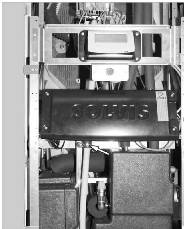
Abb. 8: Gasleitung befestigen
