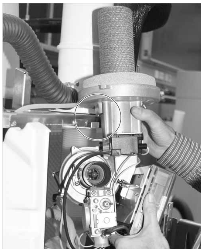
Abb. 21: Brenner in Wartungsposition
