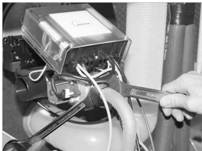
Abb. 7: Gasleitung anschließen
