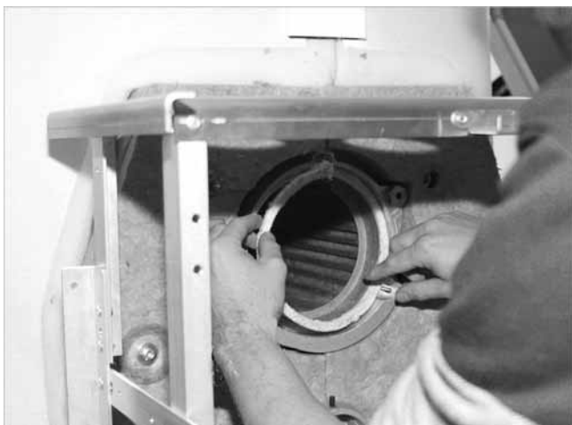
Abb. 5: Brennerdichtschnur einlegen
