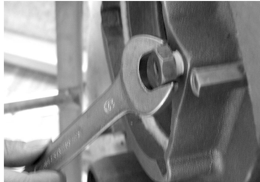
Bild 4: Tauchhülse einsetzen
