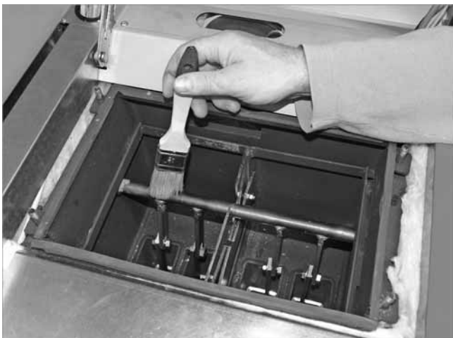
Abb. 39: Nachheizflächen reinigen
