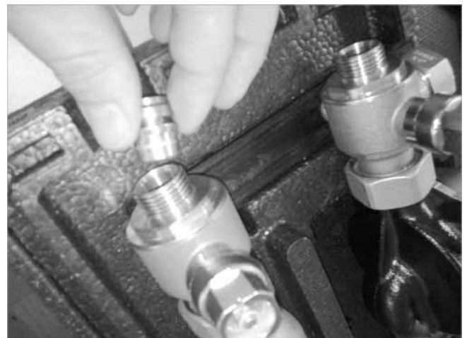
Abb. 4: Klemmringreduzierungen einsetzen
