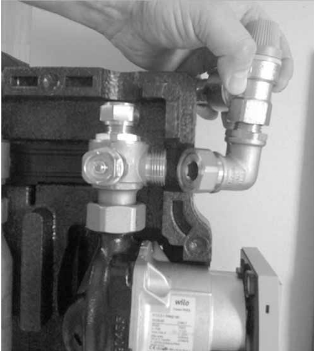
Abb. 1: Solarsicherheitsventil abschrauben
