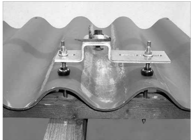
Afb. 69: Opbouw-dakbeugel gereed gemonteerd (methode B)
