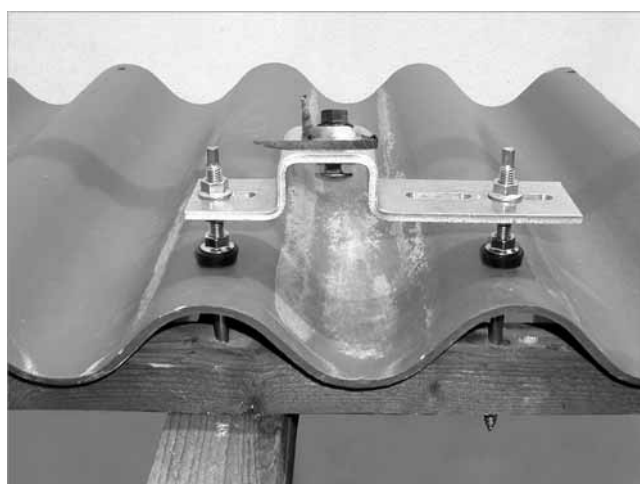
Fig. 49: Suporte para telhados aparafusado (método B)
