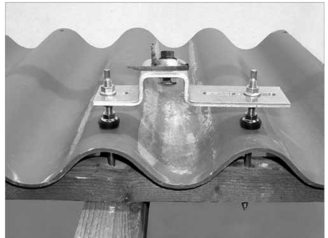
Fig. 39: Soporte sobre tejado atornillado (método B)
