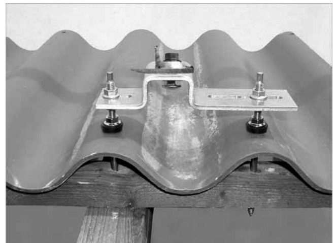
Fig. 59 : fixation sur toiture vissée (méthode B)
