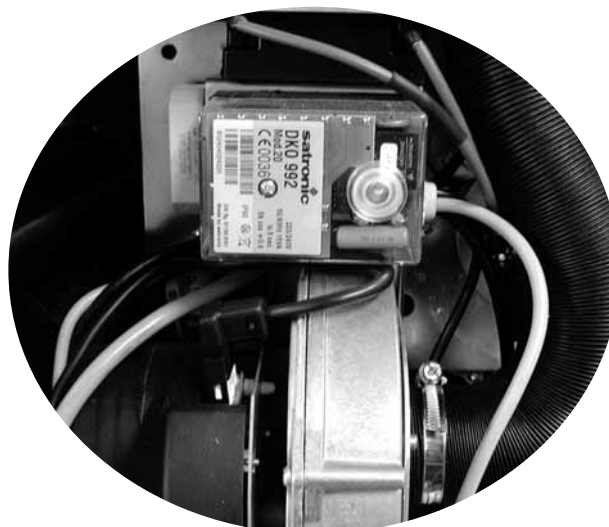
Detail-Ansicht Feuerungsautomat des SÖ BW mit Reset-Knopf
