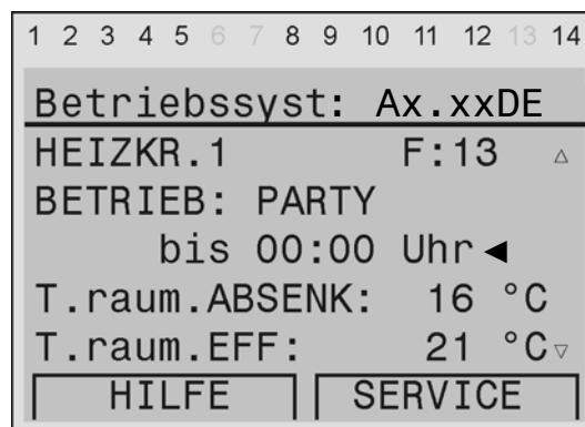
Anzeigensicht zur Einstellung des Wiederbeginns des Automatikmodus
