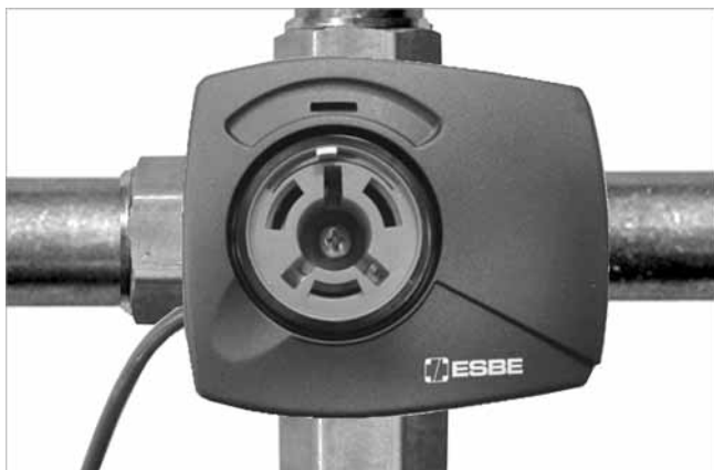
Fig. 16: Miscelatore con attuatore
