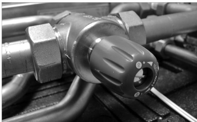
Abb. 9: Thermostatisches Mischventil an der WWS-36
