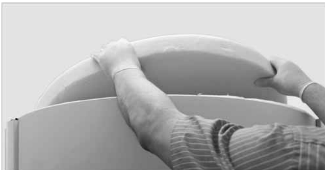
Abb. 10: Deckelronden auflegen
