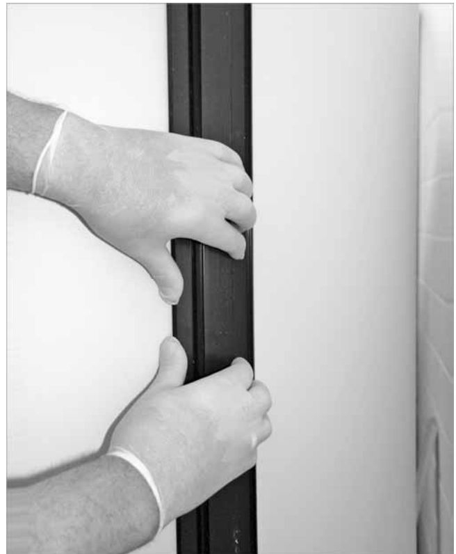
Abb. 8: Isolierteile schließen
