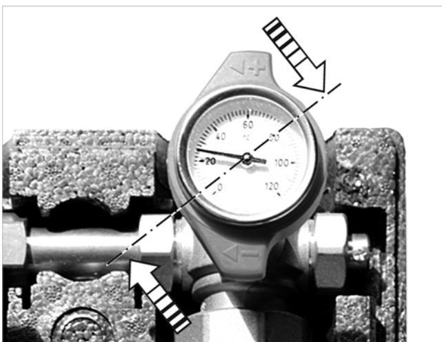
Abb. 6: Kugelhahn mit integriertem Thermometer
