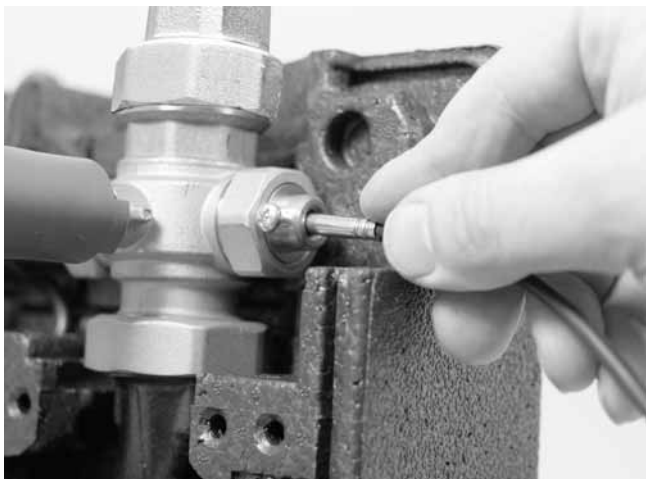
Abb. 19: Vorlauftemperaturfühler montieren
