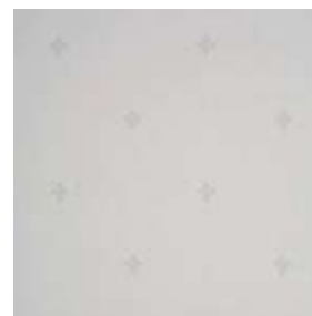
31:02 (Klass 1) Tapetserad yta kant i kant. Vid tapetsering i nyproduktion eller då alla tidigare tapeter har tagits ned vid t.ex. ombyggnad.
