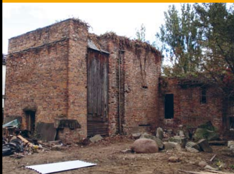
3. Pracownia Stefana Momota przy ul. Niekłańskiej 19 w ostatniej fazie swego istnienia - obecnie wyburzona. Widać rzeźby pomiędzy pozzrucanymi płytami kamiennymi. 25.IX.2009
