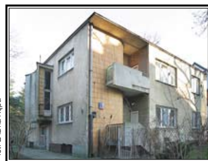
Berezynska 28, Dom Braci Ordyńskich, B. Lachert i raz J. Szanajca, 1936 i Styki 22, proj. M. Goldberg, przed 1937. Dzięki wpisowi do rejestru zabytków (obecnie domy w Gminnej Ewidencji Zabytków, co pozwala na przebudowę i rozbudowę w stronę ogrodu) budynki zachowają pierwotną formę, a właściciele będą mogli otrzymać dofinansowanie na remont.
