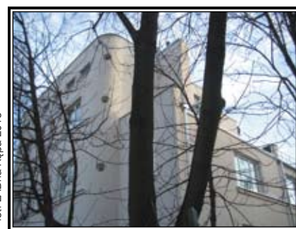
Berezynska 10, około 1936, (mylnie przypisywany S. Ogórkowi), budynek wpisany do rejestru zabytków. Przykład bardzo dobrze przeprowadzonego remontu.
