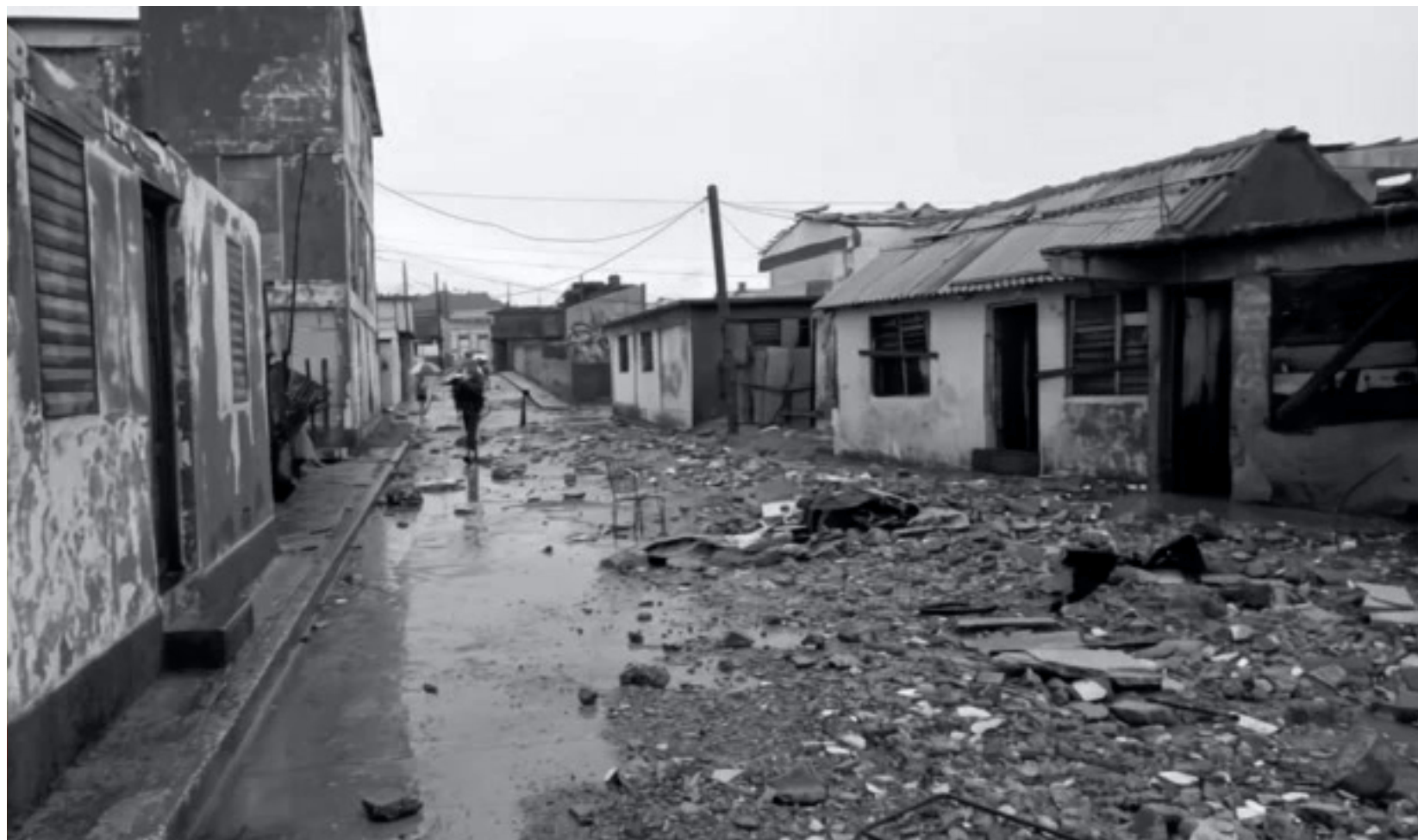
Estragos causados por el huracán Oscar en Baracoa, Guantánamo.
