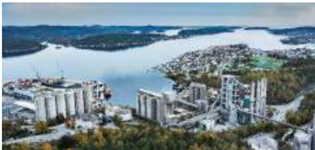
Figuur 1: CCS in Brevik Overgenomen uit: Brevik CCS - World's first CO 2 -capture facility at a cement plant door Heidelberg Materials, sd. Geraadpleegd op 20 oktober 2023, van: ( https://www.brevikccs.com/en ). Copyright, Heidelberg Materials.
