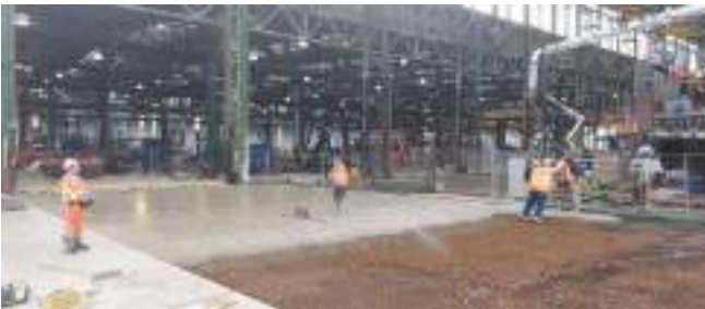
Figuur 17: Stort geopolymeerbeton vloer
