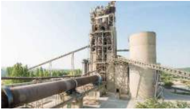
Figuur 3: LEILAC 1 in Lixhe Overgenomen uit: Afvang en opslag van koolstof door Heidelberg Cement Benelux , sd. Geraadpleegd op 20 oktober 2023, van: ( https://www.heidelbergcement.be/nl/afvang-en-opslag-van-koolstof ). Copyright, Heidelberg Cement Benelux.
