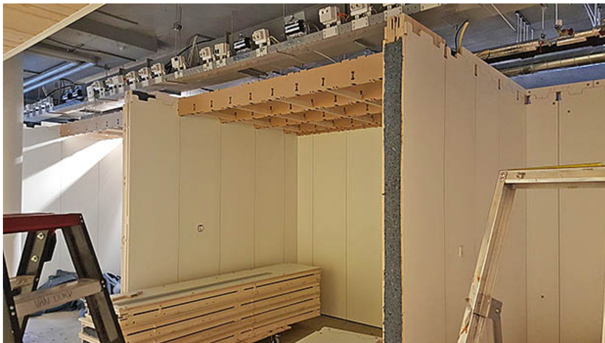
Voor vergaderruimten is er een volledig circulair wandsysteem geplaatst van TheNewMakers. Dit systeem is vervaardigd van 100% gerecycled materiaal en volledig zonder bevestigingsmiddelen en/of lijm gemonteerd en eenvoudig demontabel.
