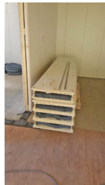
Voor vergaderruimten is er een volledig circulair wandsysteem geplaatst van TheNewMakers. Dit systeem is vervaardigd van 100% gerecycled materiaal en volledig zonder bevestigingsmiddelen en/of lijm gemonteerd en eenvoudig demontabel.
