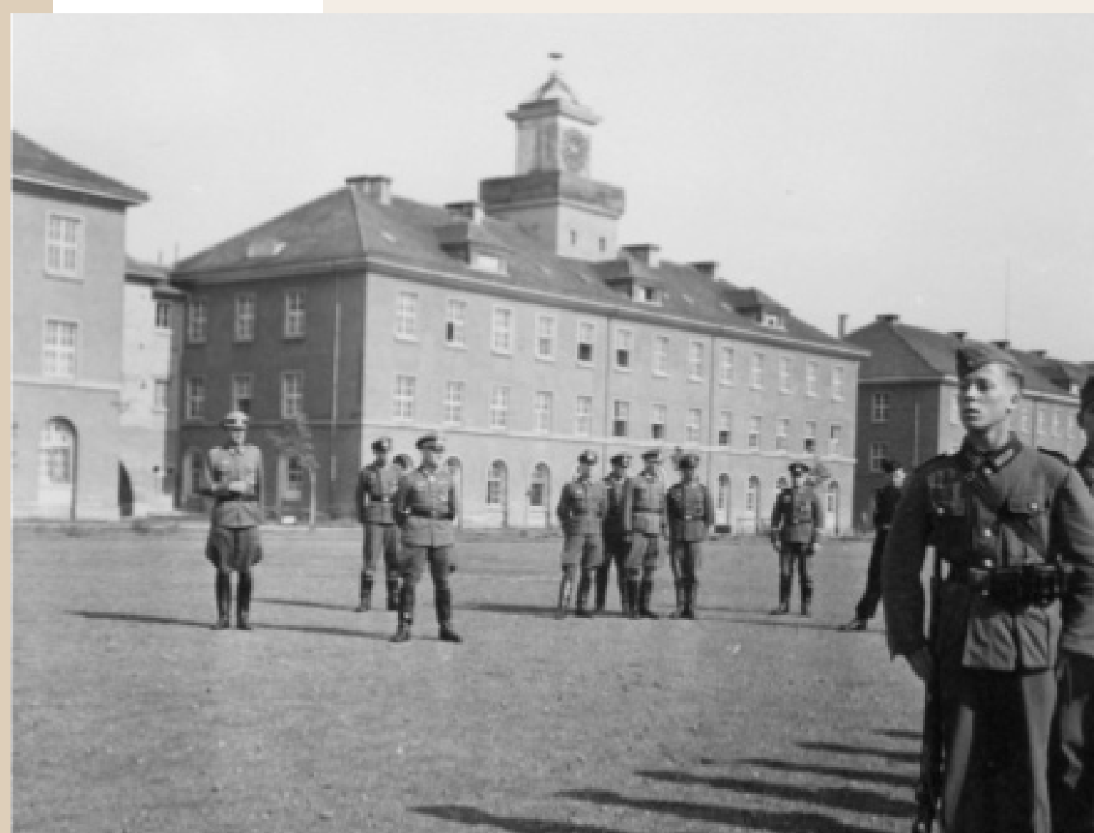
Die ehemalige Turennekaserne 1944
