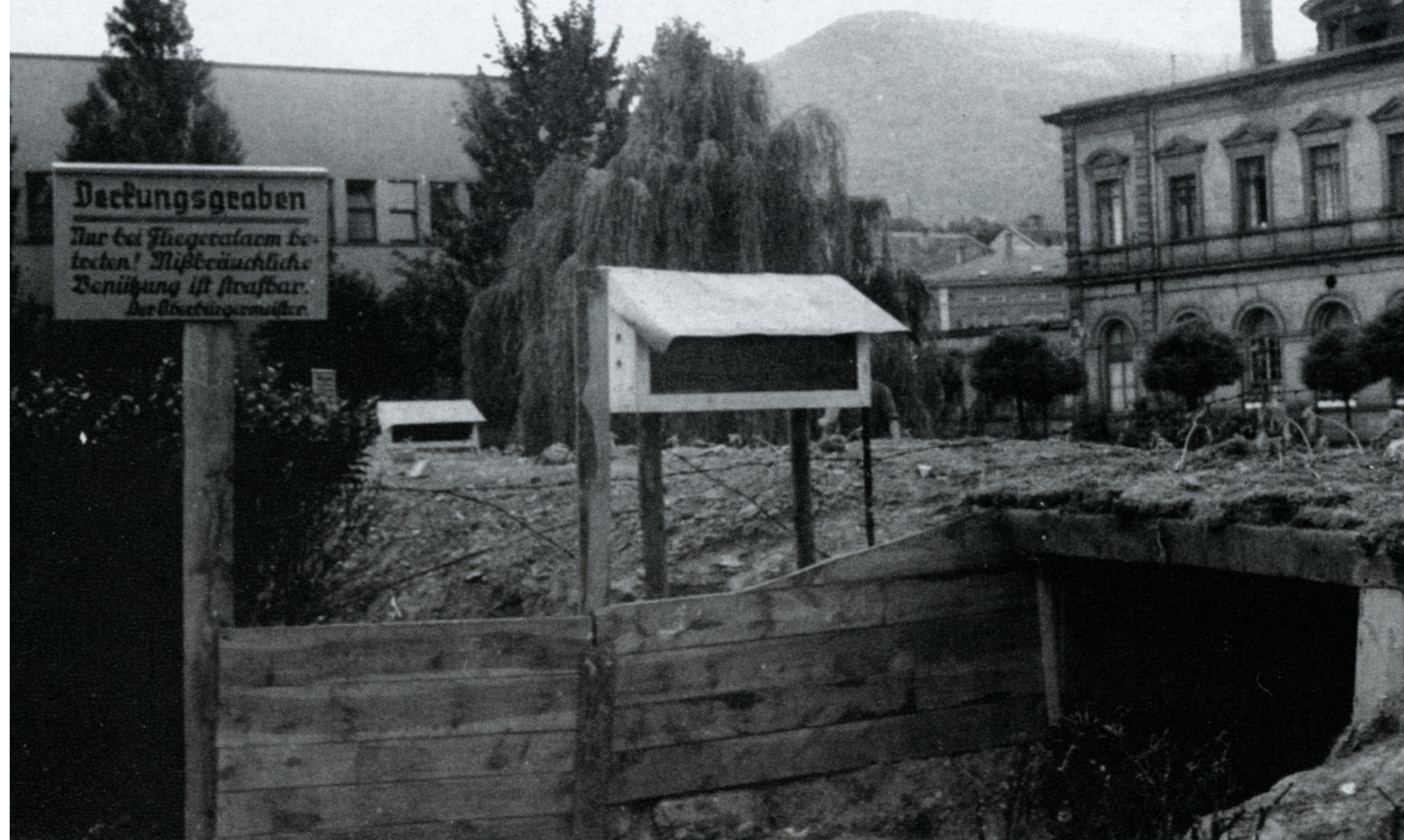
Deckungsgraben in der Nähe des Saalbaues
