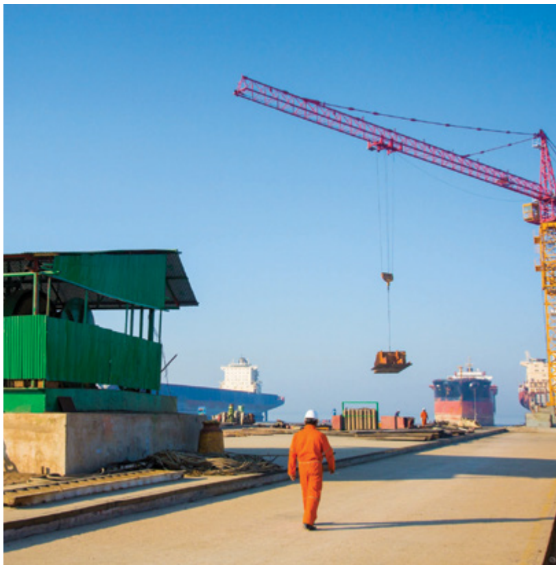
Η ίδια μονάδα ανακύκλωσης πλοίων στο Μπανγκλαντές μετά την εθελοντική της αναδιάρθρωση για τη συμμόρφωση με την ΗΚΚ.
