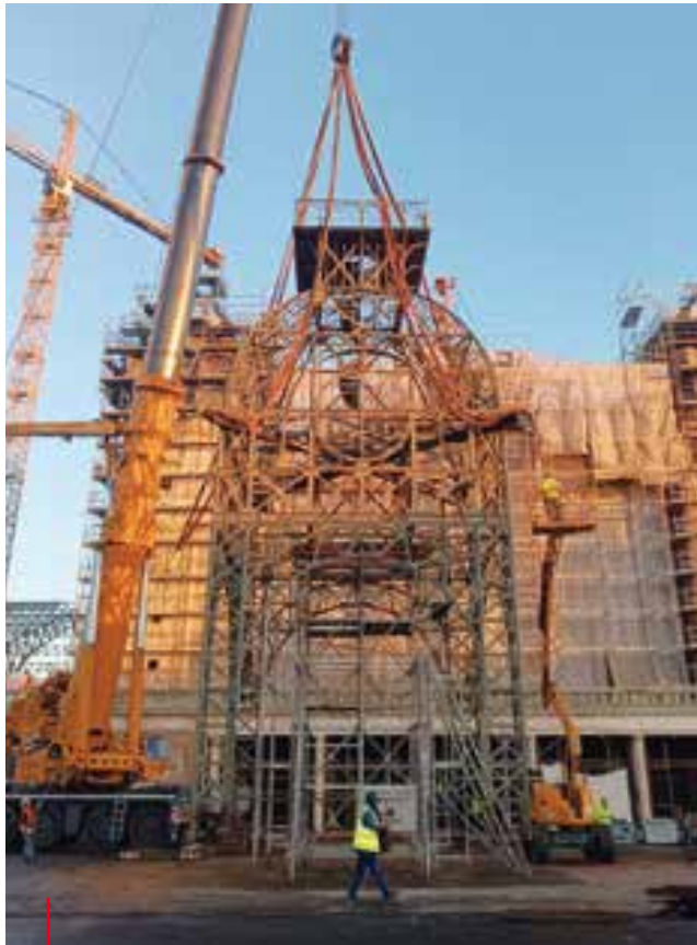
Využití zdvihacích zařízení při manipulaci s břemeny Use of lifting equipment for load handling
