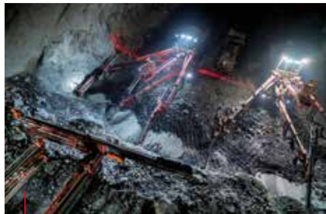
Výstavba podzemních kaveren pro ukládání odpadu z důlní činnosti, Norsko Construction of underground caverns for the storage of mining waste, Norway
