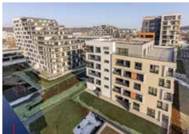
Výstavba bytových domů Tesla Hloubětín – II. a IV. etapa, Praha Construction of Tesla Hloubětín apartment buildings – stages II and IV, Prague
