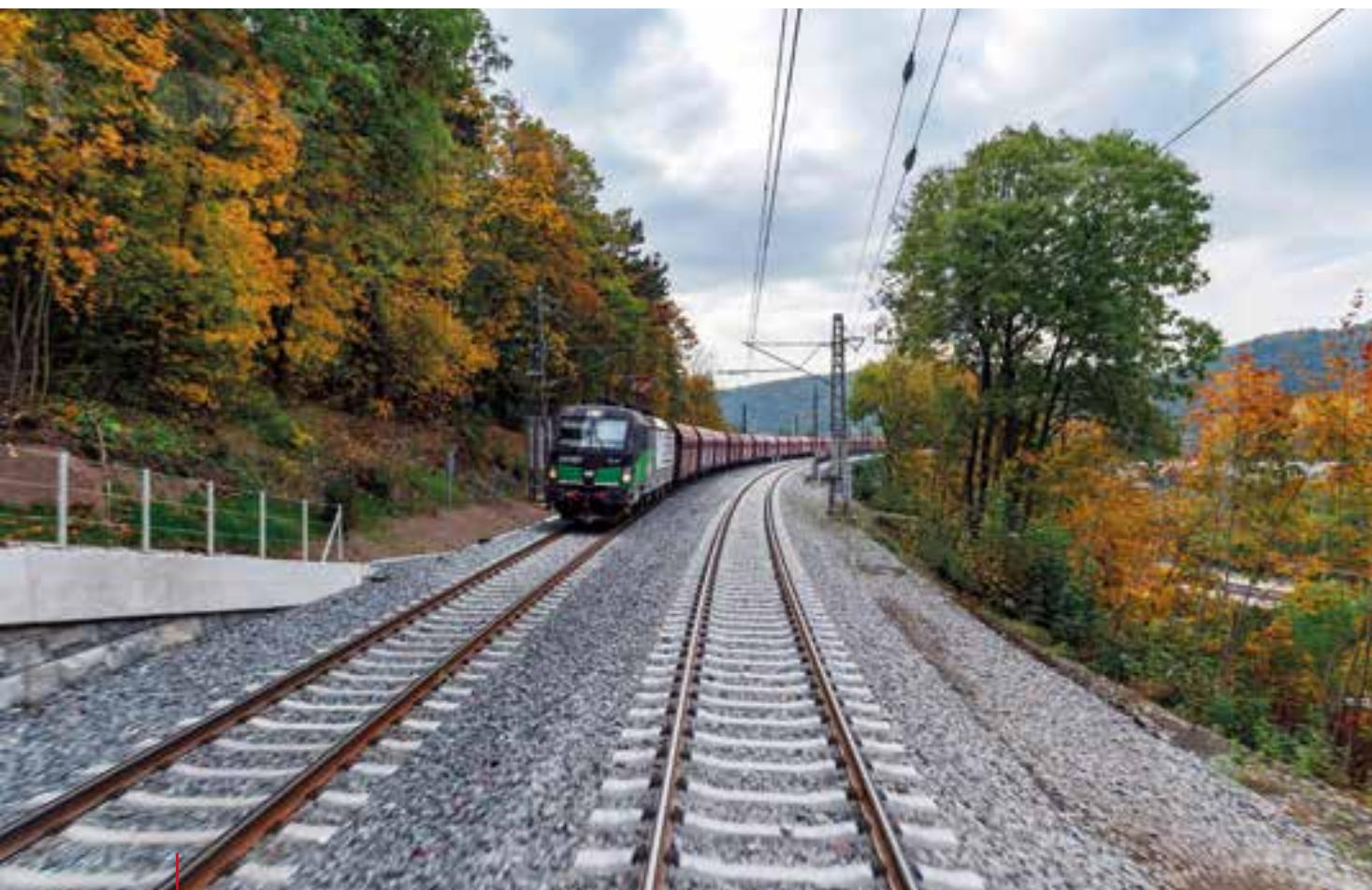
Zdvoukolejnění trati Branický most – Spořilov, Praha Double-tracking of the Branický bridge – Spořilov line, Prague
