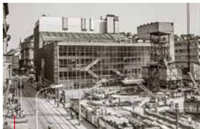
Staveniště vestibulu metra vedle obchodního domu Máj na Národní třídě, 1980 Construction site of the metro entrance hall next to the Máj department store on Národní třída, 1980
