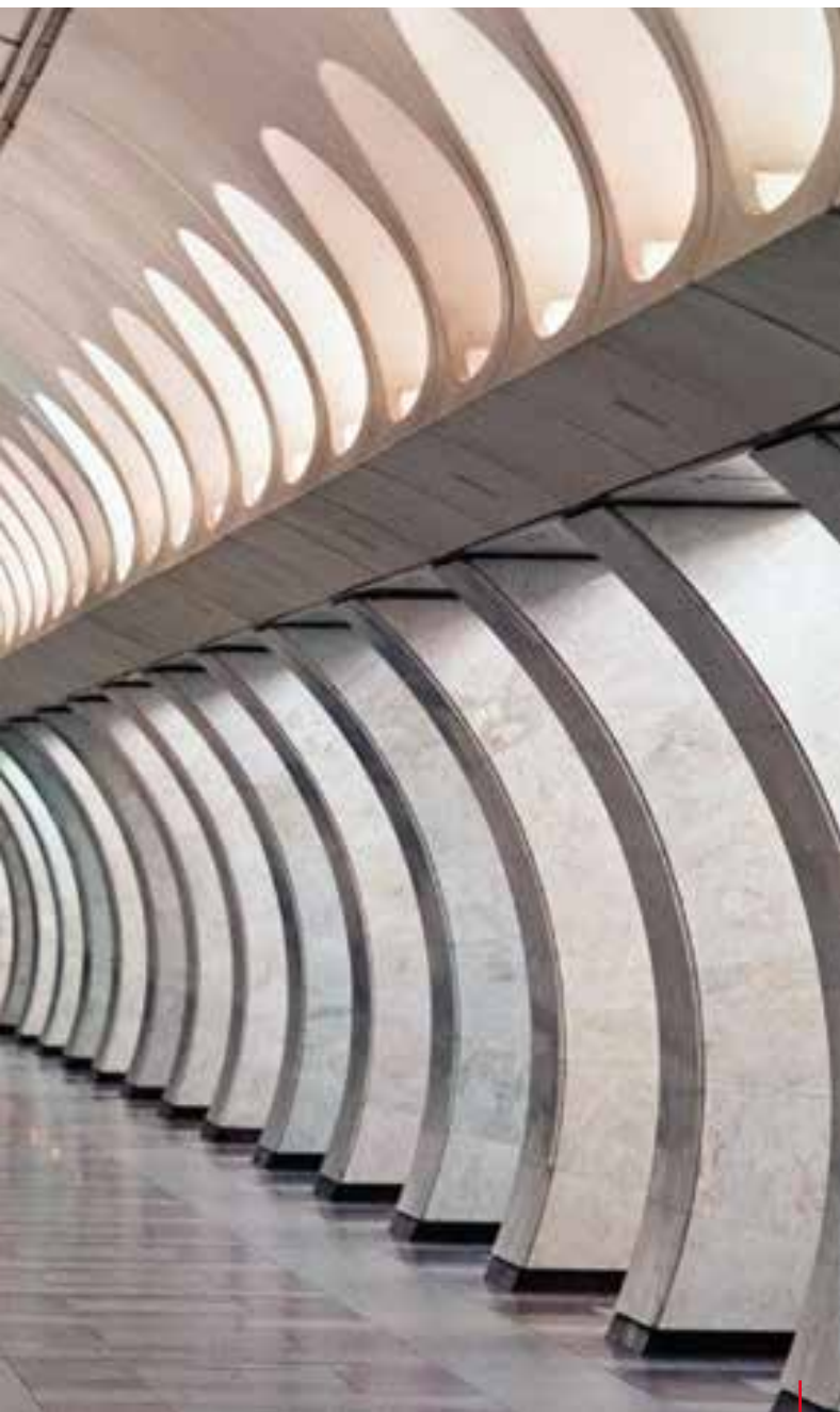
Nástupiště stanice Anděl tvoří kombinace červené a šedé žuly stejně jako pilíře jsou obloženy leštěným světlým mramorem. The Anděl station platform is finished in a combination of red and grey granite, with the pillars clad in polished light marble.
