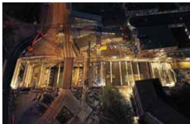
Výstavba úseku metra linky U4 Manshardtstrasse, Hamburk Construction of the Manshardtstrasse section of the U4 metro line, Hamburg
