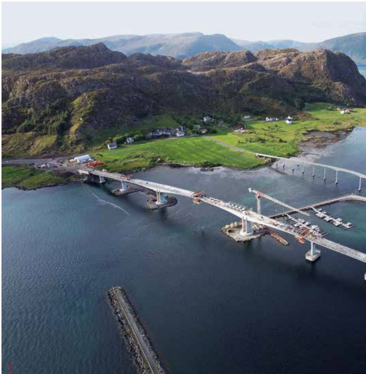
Výstavba mostu Ny Nerlandsøybrua, Norsko Construction of the Ny Nerlandsøybrua Bridge, Norway
