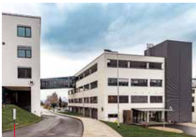
Výstavba nemocnice – pavilon pro matku a dítě, Děčín Construction of a hospital – maternity and paediatric pavilion, Děčín
