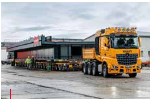
Převoz mostní konstrukce vyrobené v provozu ocelových konstrukcí, Horní Počernice Transport of a bridge structure manufactured at the steel-structures facility in Horní Počernice
