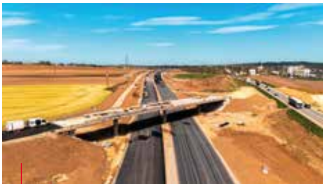
Výstavba dálnice D35 Sadová–Plotiště Construction of the D35 motorway in the Sadová–Plotiště section
