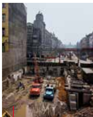
Výstavba stanice Můstek na Václavském náměstí, 1975 Construction of Můstek station on Václavské náměstí, 1975
