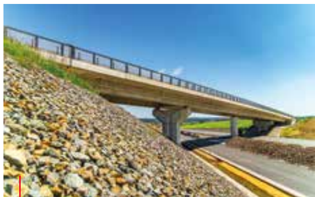
Výstavba dálnice D35 Janov–Opatovec Construction of the D35 motorway in the Janov–Opatovec section
