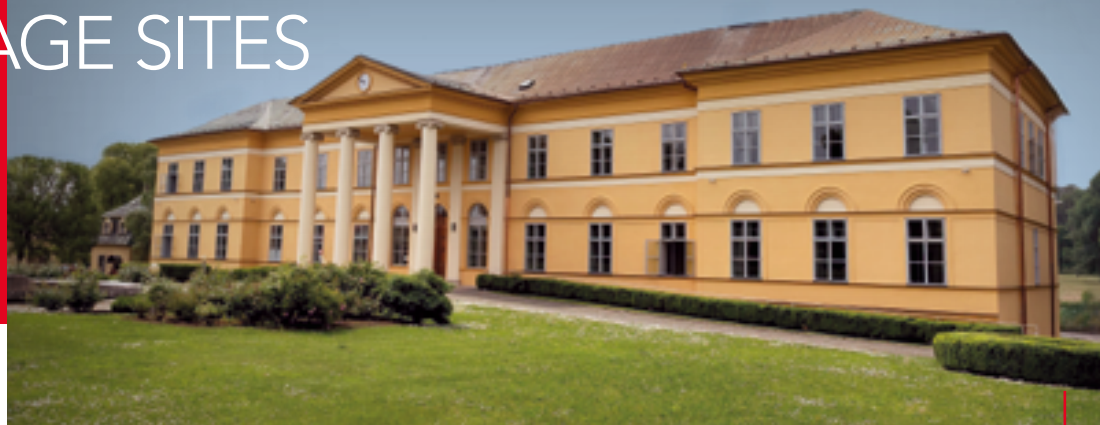
Rekonstrukce zámku Dolná Krupá, Slovensko Reconstruction of Dolná Krupá Chateau, Slovakia
