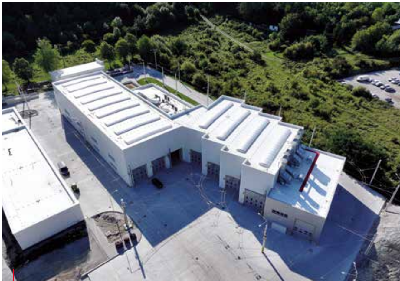
Dokončení 1.–3. etapy trolejbusového depa v Žilině, Slovensko Completion of stages 1–3 of a trolleybus depot in Žilina, Slovakia
