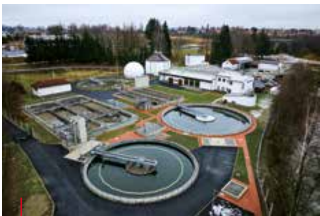
Modernizace a intenzifikace ČOV, Žďár nad Sázavou – Stavba roku 2025, Cena za mimořádný přínos pro životní prostředí Modernisation and intensification of the wastewater treatment plant in Žďár nad Sázavou – Building of the Year 2025, Award for Outstanding Contribution to the Environment
