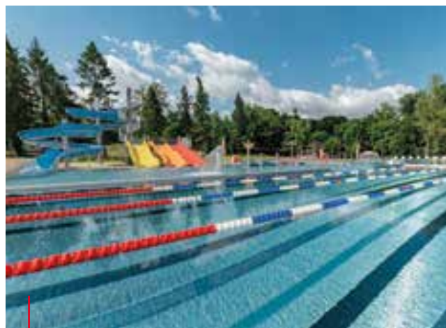
Modernizace plovárny Slaný – Stavba roku Středočeského kraje 2025 Modernisation of the Slaný swimming complex – Central Bohemian Region Building of the Year 2025
