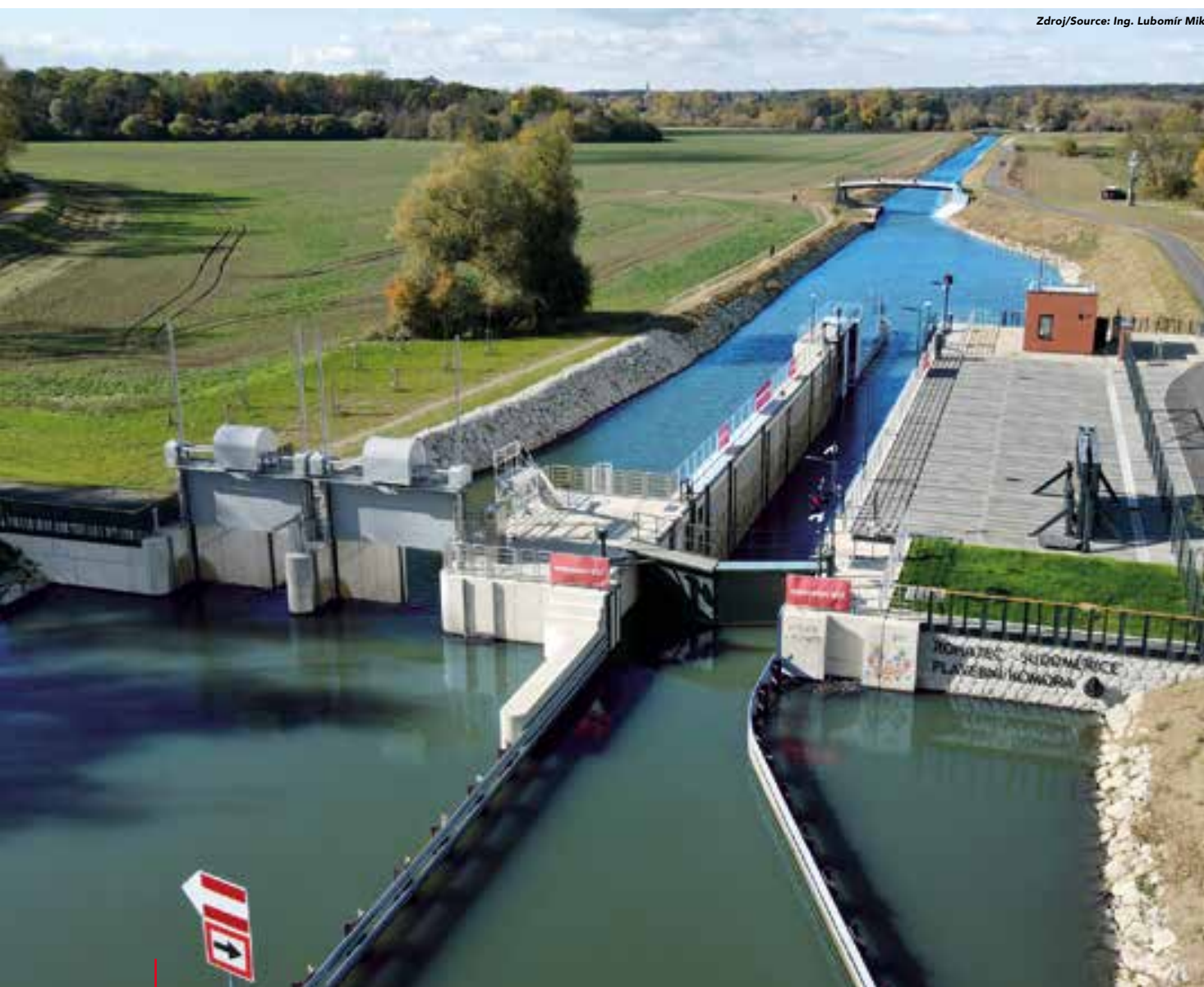
Rekonstrukce plavební komory Rohatec a jezu Sudoměřice Reconstruction of Rohatec lock and Sudoměřice weir
