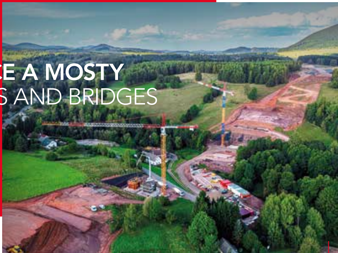
Výstavba dálnice D11 Trutnov – státní hranice ČR/PL Construction of the D11 motorway in the Trutnov–Czech/Polish border section
