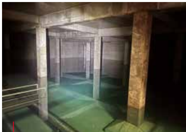
Výstavba vodojemu Bukovno, Jihlava Construction of Bukovno reservoir, Jihlava
