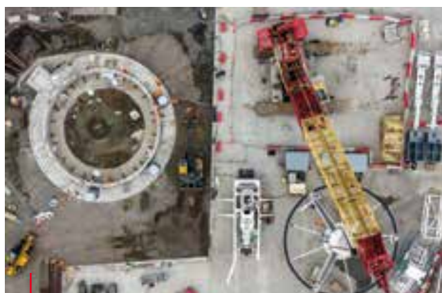
Výstavba kabelového tunelu Tillbury pod Temží, Velká Británie Construction of the Tillbury cable tunnel beneath the Thames, Great Britain
