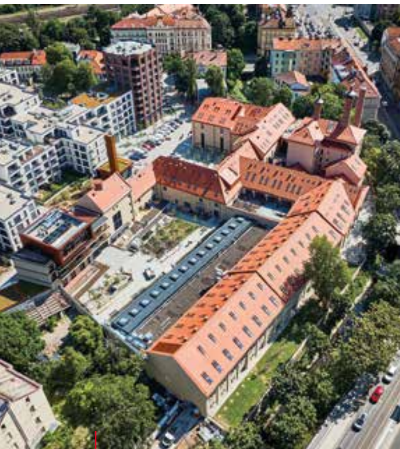
Konverze Nuselského pivovaru na bytový komplex, Praha Conversion of Nusle Brewery into an apartment complex, Prague
