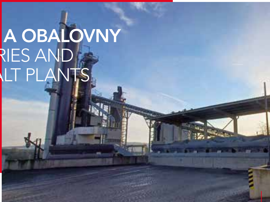
Západočeská obalovna Západočeská Asphalt Mixing Plant
