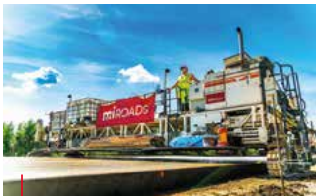
Rekonstrukce dálnice D5 u Nové Hospody Reconstruction of the D5 motorway near Nová Hospoda
