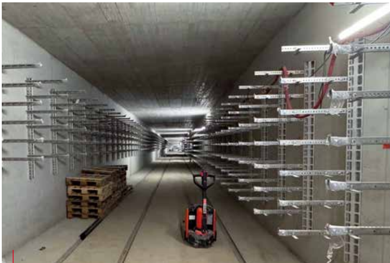
Výstavba kolektoru na letišti, včetně trafostanice, Praha Construction of a utility tunnel at the airport, including a transformer station, Prague
