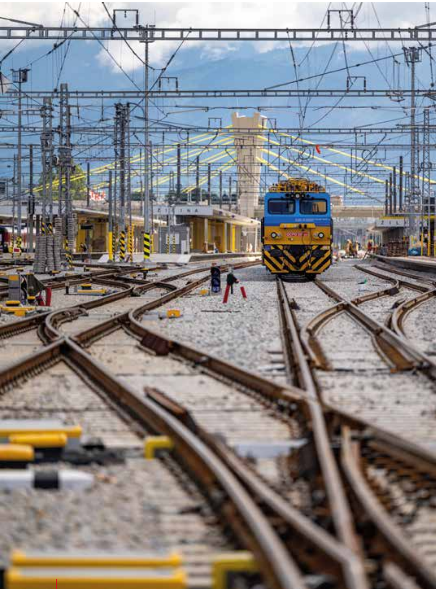
Rekonstrukce železniční stanice Žilina, Slovensko Reconstruction of Žilina railway station, Slovakia
