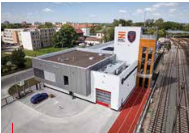
Výstavba Hasičského záchranného sboru Správy železnic, Nymburk Construction of the Railway Administration Fire and Rescue Service site, Nymburk
