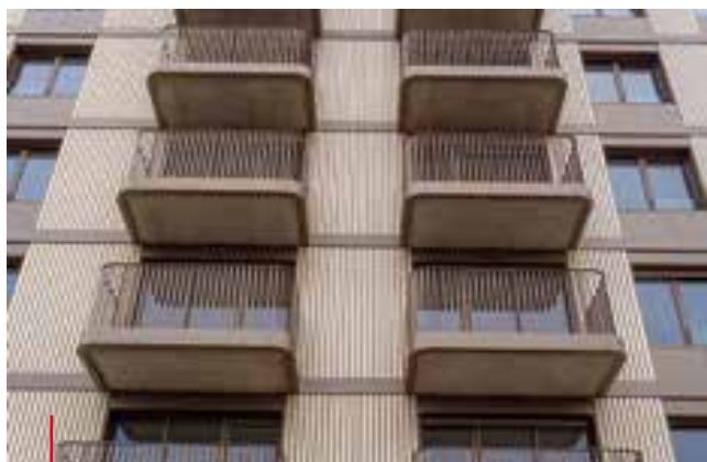
Zhotovení provětrávaného fasádního pláště a hliníkových výplní otvorů bytového domu Millhaus, Bratislava, Slovensko Installation of the ventilated façade cladding and aluminium window and door infills for the Millhaus residential building, Bratislava, Slovakia
