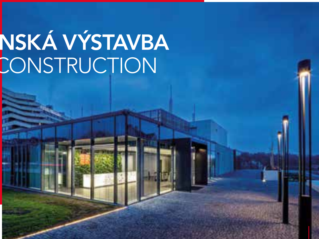
Výstavba II. etapy stavební části MOS Malovanka, Praha Construction of the 2 nd stage of Multifunctional Operating Centre Malovanka, Prague
