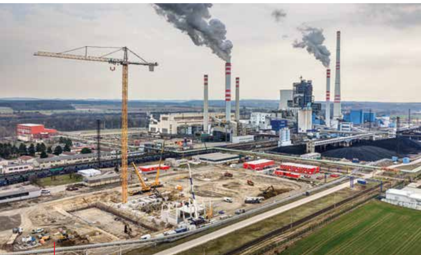
EPC výstavba ZEVO Mělník EPC of the WtE plant Mělník
