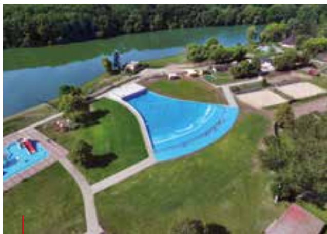
Výstavba bazénu s vlnobitím, Rimavská Sobota, Slovensko Construction of a wave pool, Rimavská Sobota, Slovakia
