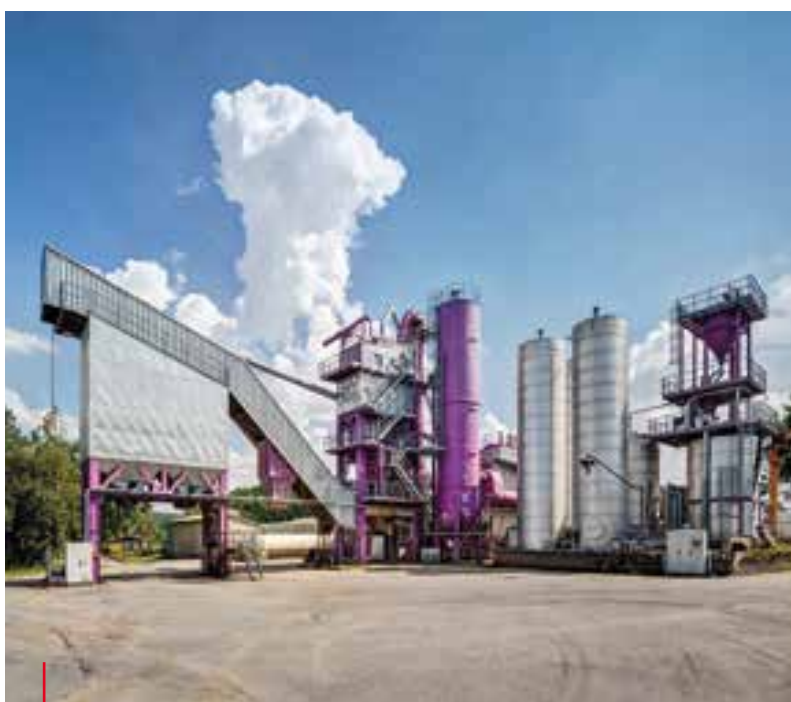
Obalovna Líchovny Líchovny Asphalt Mixing Plant
