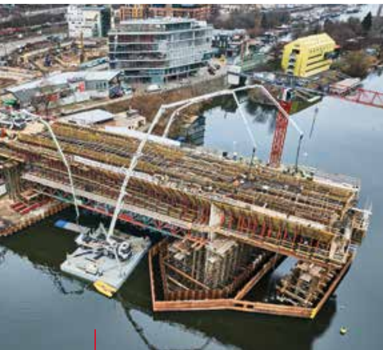
Výstavba Dvoreckého mostu, Praha Construction of Dvorecký Bridge, Prague
