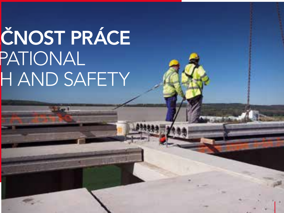
Zajištění pracovníků při práci ve výškách Safety measures for workers performing tasks at height
