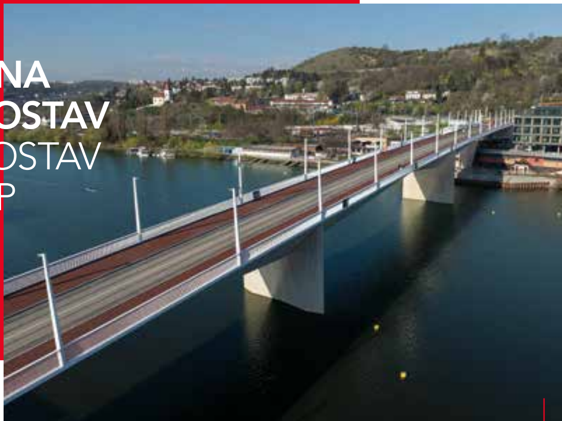
Dvorecký most, Praha Dvorecký bridge, Prague
