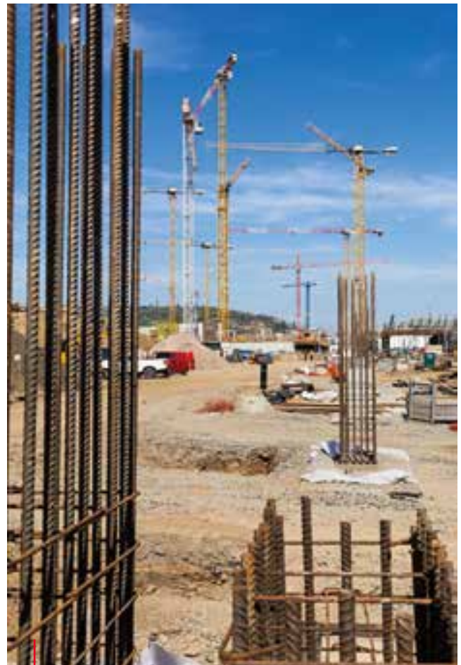
Rekonstrukce železniční stanice Praha-Smíchov Reconstruction of Prague-Smíchov railway station
