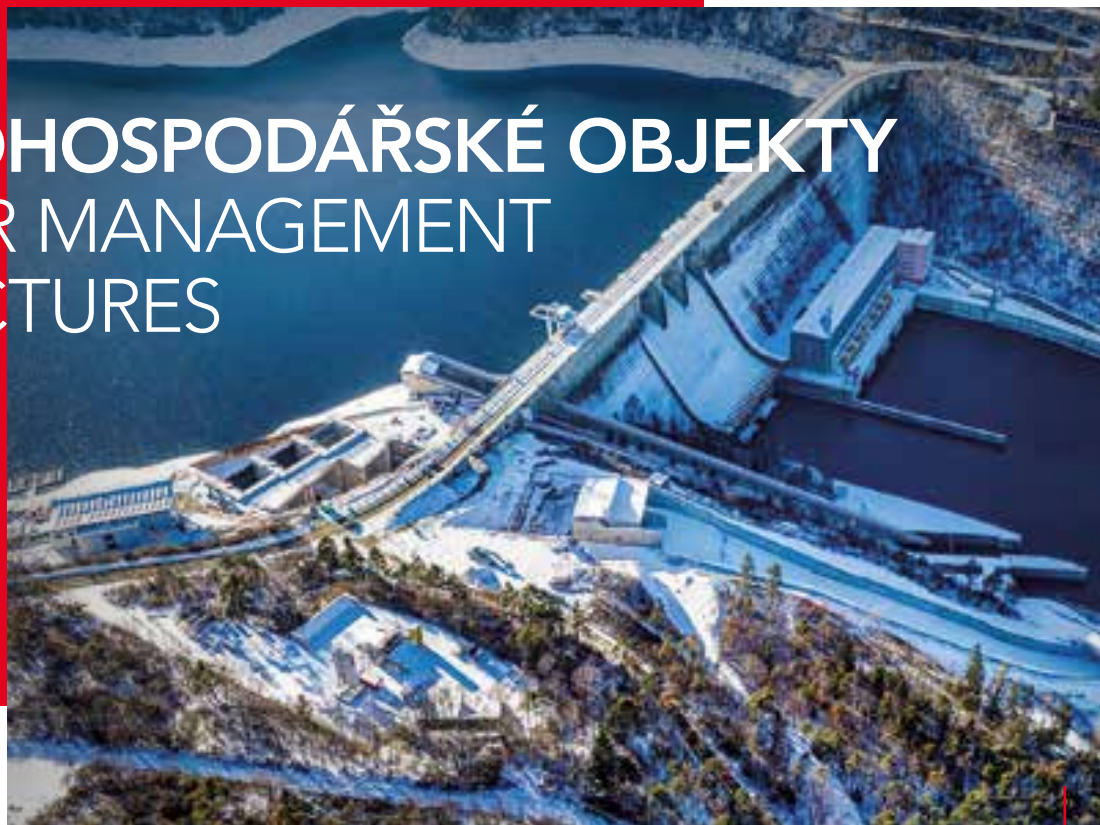
Výstavba bezpečnostního přelivu VD Orlík, Milešov-Klenovice Construction of Orlík Hydraulic Structure safety spillway, Milešov-Klenovice
