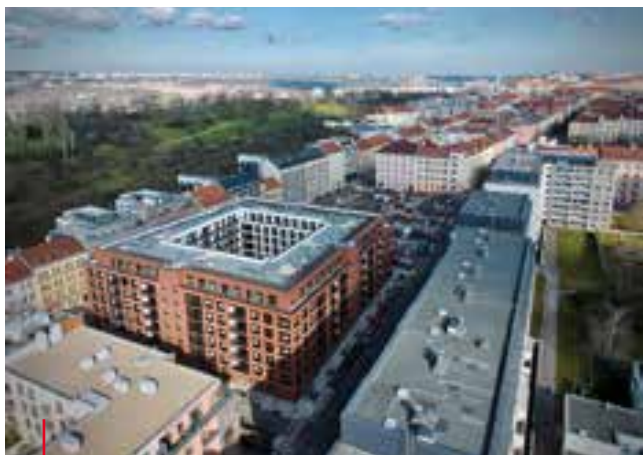
Výstavba bytových domů Vivus Žižkov, Praha Construction of Vivus Žižkov apartment buildings, Prague
