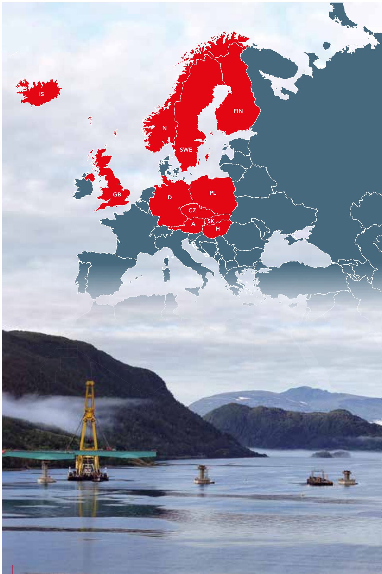
Výstavba mostu Ramfjord E8 Sørbotn–Laukslett, Norsko Construction of the Ramfjord Bridge, E8 Sørbotn–Laukslett, Norway
