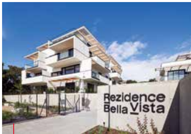
Výstavba viladomu Hrachovka, Rezidence Bella Vista, Praha Construction of Hrachovka villa building complex, Rezidence Bella Vista, Prague
