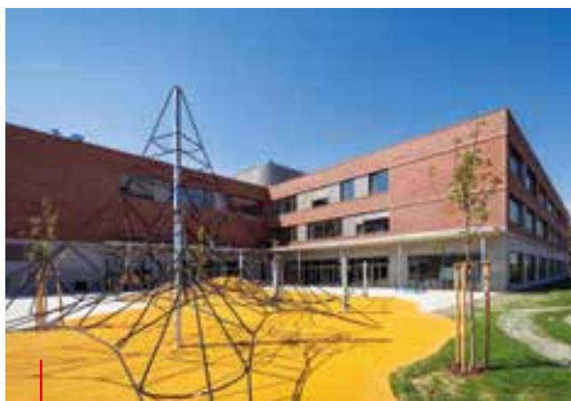
Výstavba svazkové ZŠ Chýně – Hostovice Construction of the Chýně–Hostovice association primary school
