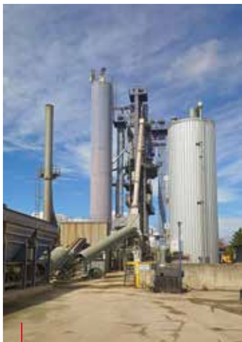
Obalovna České Budějovice České Budějovice Asphalt Mixing Plant
