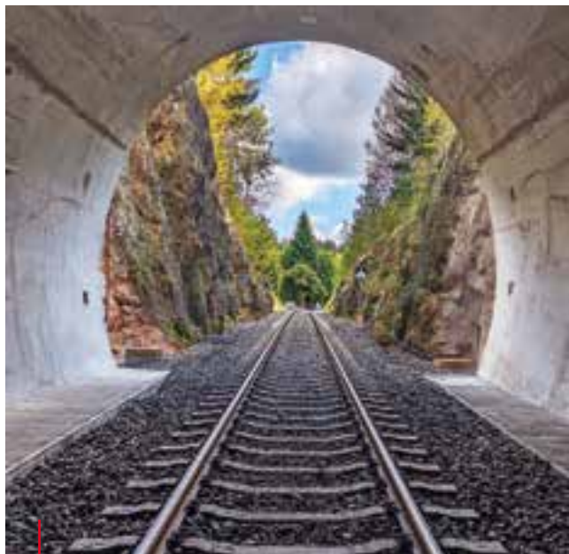
Dolnolučanský tunel v trati Liberec–Harrachov Dolnolučanský Tunnel on the Liberec – Harrachov line
