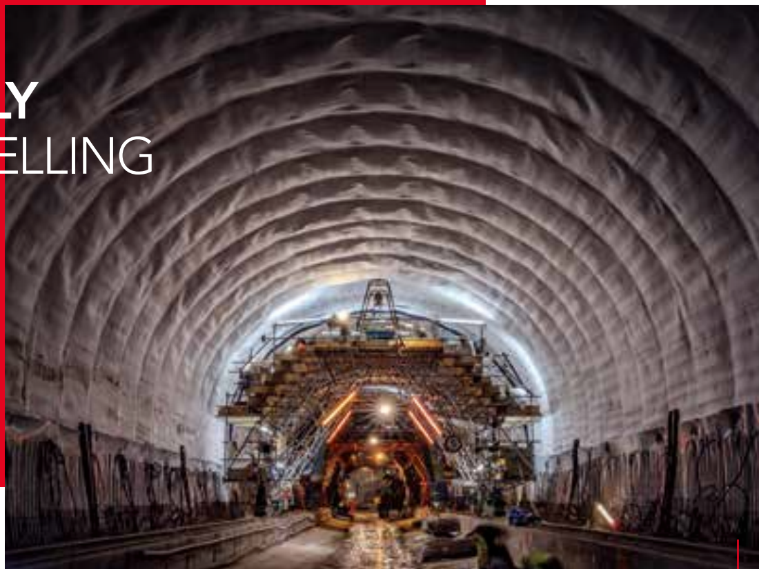
Silniční tunel, Bad Bergzabern, Německo Road tunnel, Bad Bergzabern, Germany
