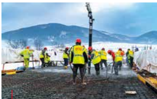
Výstavba dálnice D11 Trutnov – státní hranice ČR/PL Construction of the D11 motorway in the Trutnov–Czech/Polish border section
