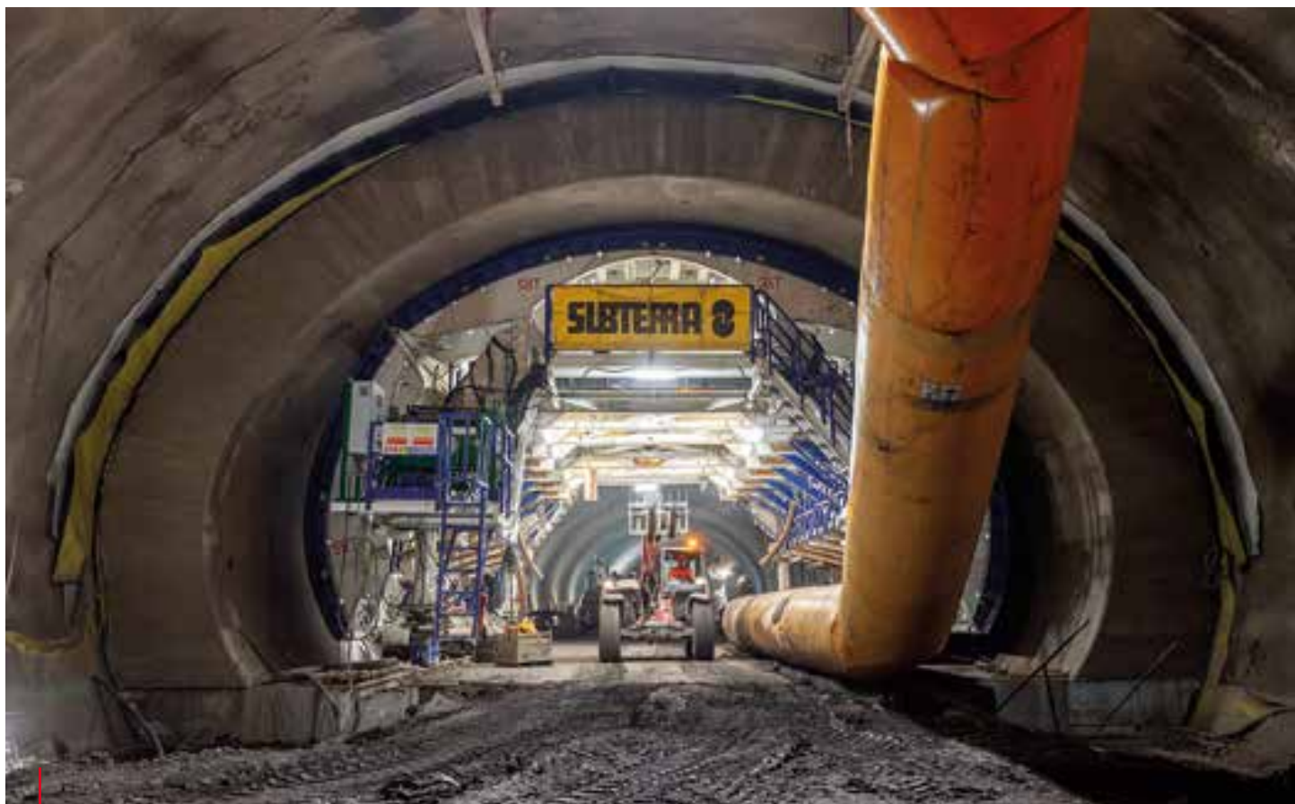
Výstavba trasy I. D metra, Praha Construction of the I.D metro line, Prague
