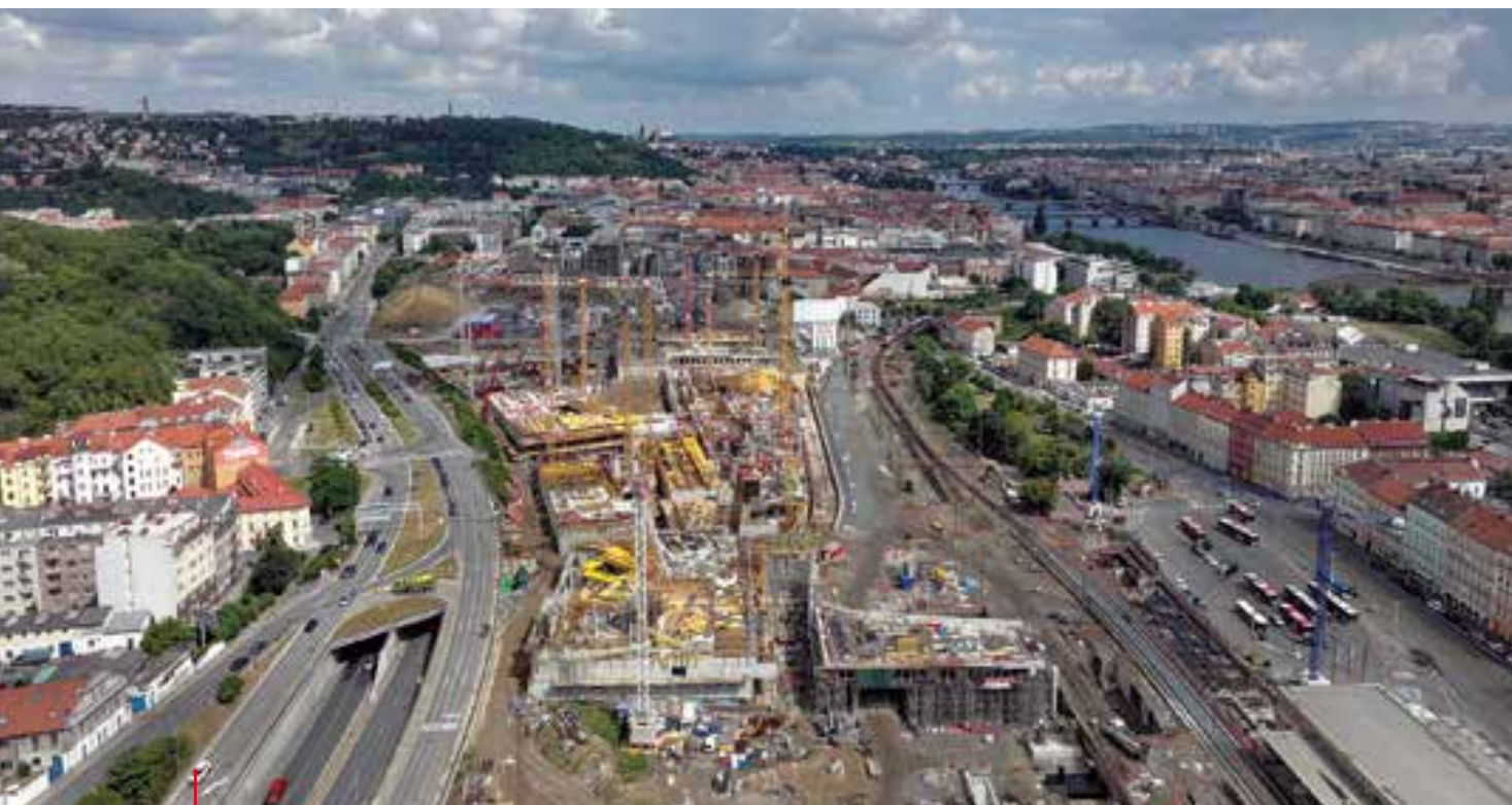
Výstavba administrativních budov OLOW 1 a 2 Smíchov City, Praha Construction of the OLOW 1 and 2 office buildings at Smíchov City, Prague
