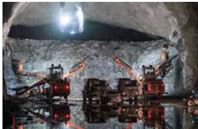
Výstavba podzemních kaveren pro ukládání odpadu z důlní činnosti pro společnost Boliden, Norsko Construction of underground caverns for the storage of mining waste for Boliden, Norway
