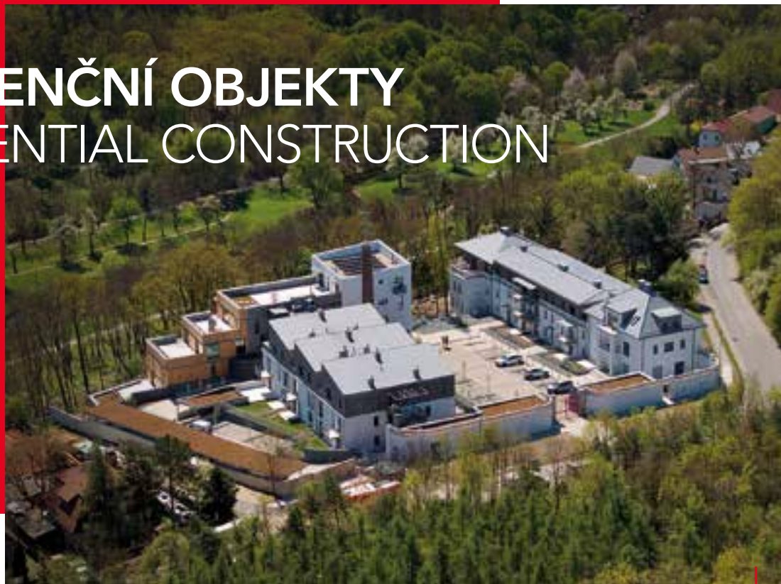
Výstavba bytového domu Harmonia Hrdlořezy, Praha Construction of Harmonia Hrdlořezy apartment building, Prague
