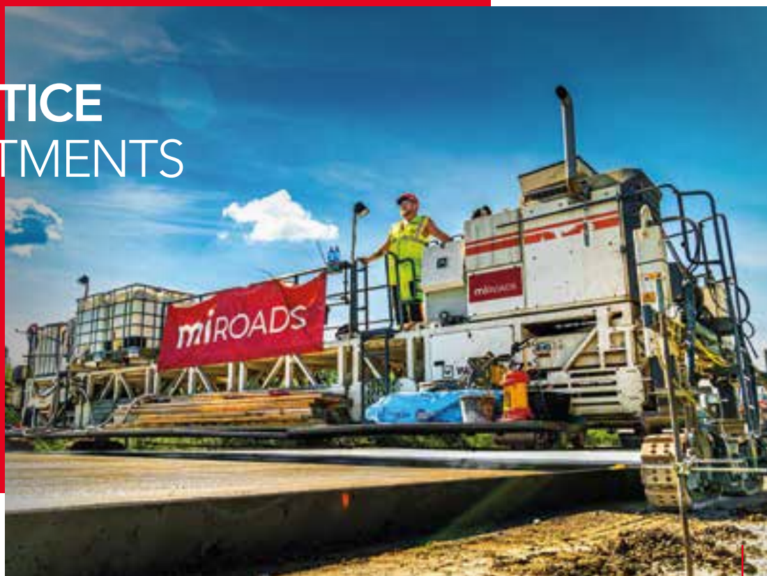
Rekonstrukce CB krytu na dálnici D5 Repair of the cement-concrete layer, D5 motorway
