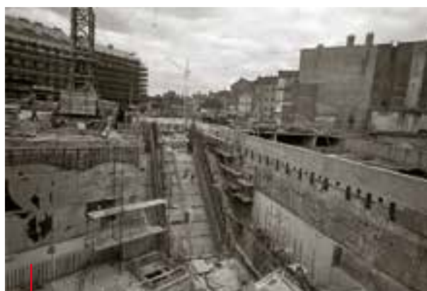
Smíchovské nádraží, jediná hloubená stanice z celkem 7 stanic. Ostatní jsou ražené. Rok 1982 Smíchovské nádraží, the only cut-and-cover station out of the total of seven. The rest were mined. 1982
