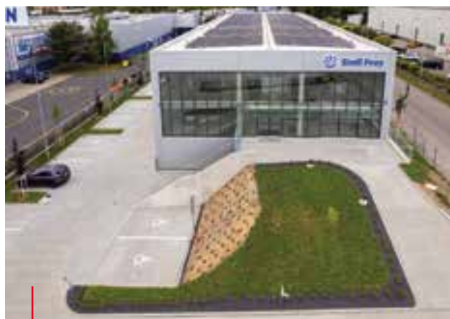
Výstavba servisního zázemí Emil Frey, Praha Construction of an Emil Frey service centre, Prague
