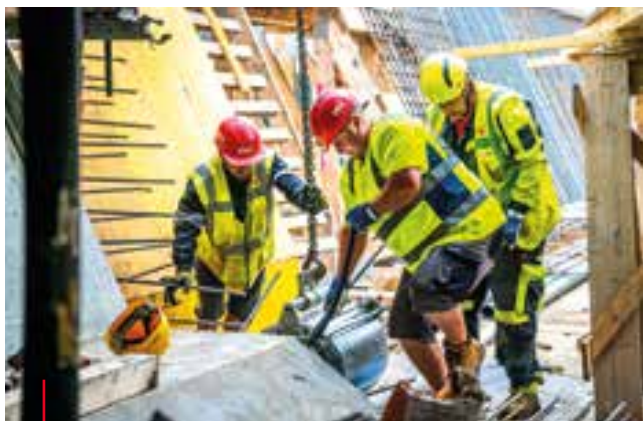
Součástí realizace mostních objektů je také know-how Střediska předpínání MI Roads a.s. The construction of these bridge structures also draws on the expertise of the MI Roads a.s. Prestressing Centre
