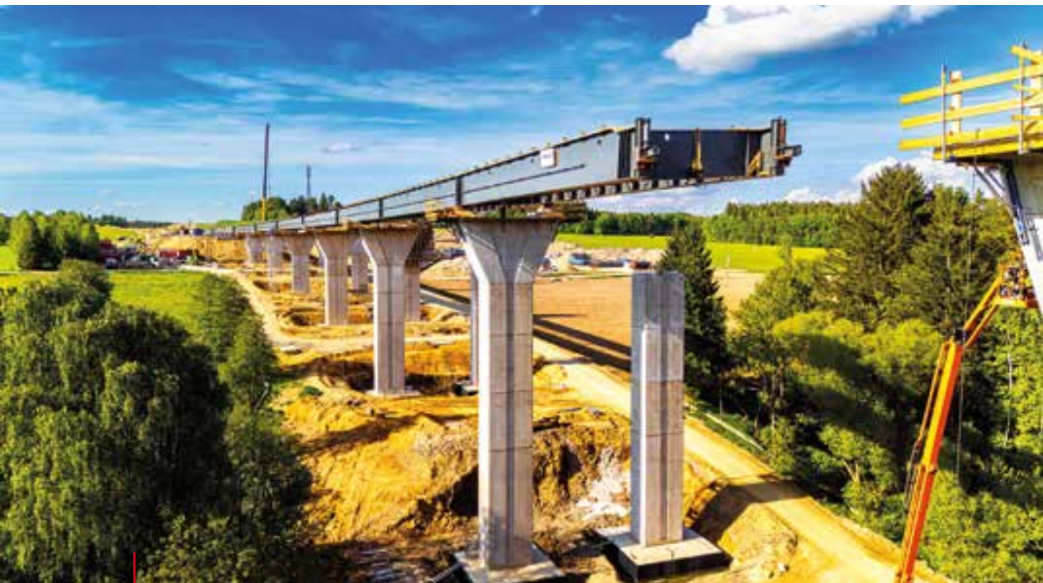
Výstavba dálnice D3 Kaplice nádraží–Nažidla Construction of the D3 motorway in the Kaplice railway station–Nažidla section
