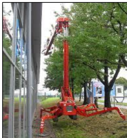
vast opgestelde hoogwerker ivm ondergrond
