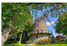
1 Moulin Flemming 1815 Canada 5 Verdiepingen
