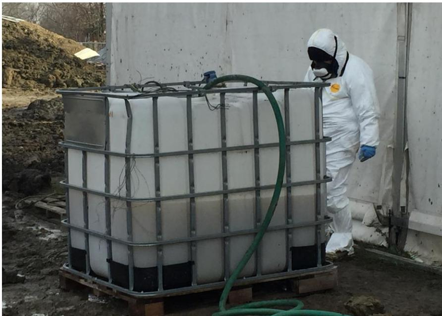
*Figura 13, 14: Applicazione dei microrganismi nella biopila da parte di un operatore (Si ringrazia per le immagini la Dott.ssa Ilaria Re, del consorzio Italbiotec)*
