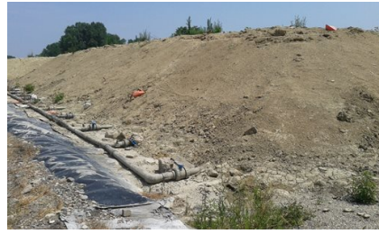
ALLESTIMENTO DI UNA "BIOPILA" PER IL TRATTAMENTO DI SUOLO CONTAMINATO CON MICROORGANISMI (BATTERI E FUNGHI)
