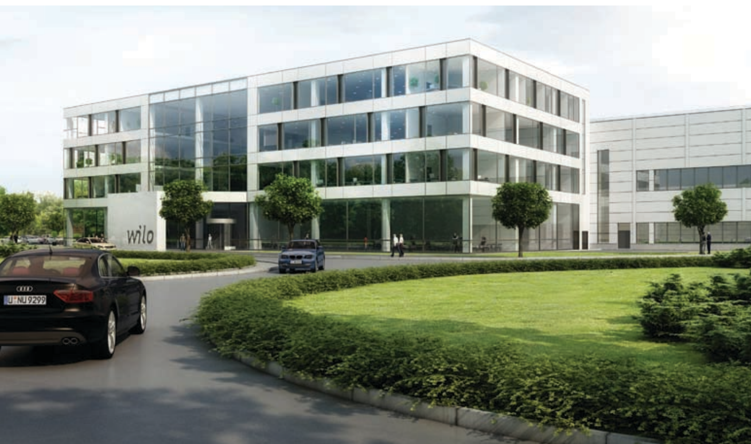
Завод в г. Ногинск, МО
