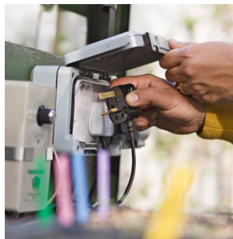
Zorg ervoor dat elektrische apparaten in de kas beschermd zijn tegen vocht.
