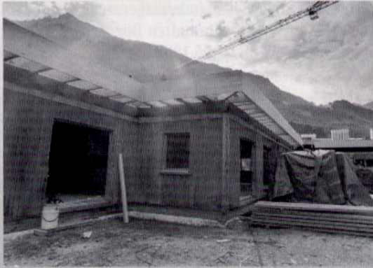
So präsentiert sich der ins Habersfeld verpflanzte, ehemalige Schulpavillon Mitte Juni. Bis im Herbst ist die Anlage fertiggestellt.
