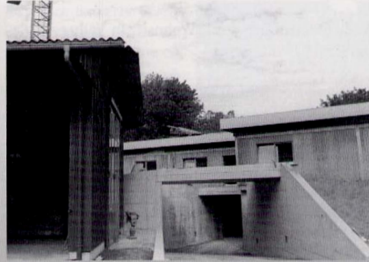
Eine Unterführung sorgt für direkten Zugang zum nahegelegenen Werkhof der Gemeinde.
