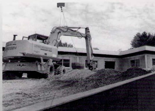
Szene von der Baustelle Kindergarten/Kinderhort Haberfeld: Planierarbeiten mit Hilfe eines Baggers.
