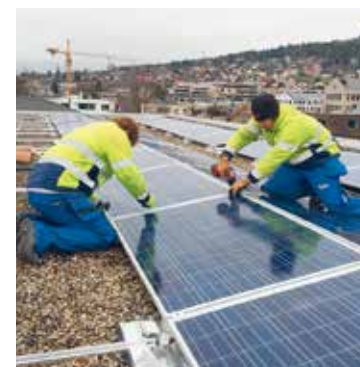
Montagearbeiten auf dem Flachdach der Turnhalle Primarschule Äule.
