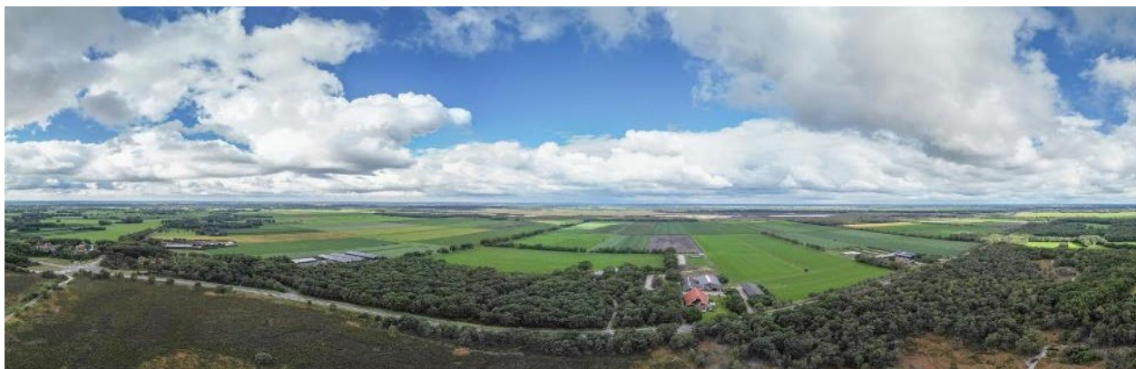
Figuur 2-23. Luchtfoto plangebied met op voorgrond de bufferzone en op achtergrond Engbertsdijksvenen (bron: A. Voerman).
