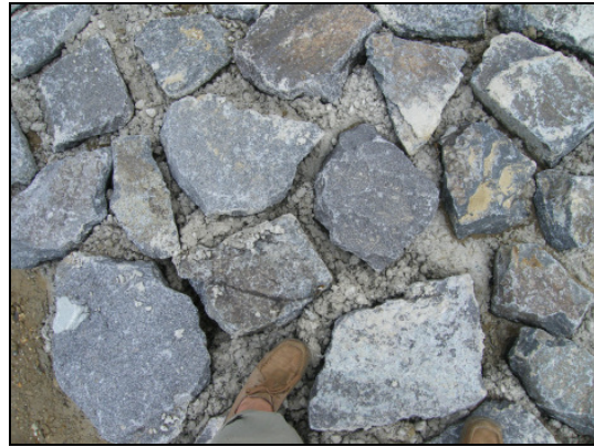
23. ábra. hídpillér menti borítás minősége – helyenként fél méteres résekkel
