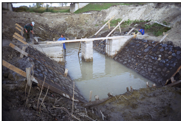
25. ábra. Fenékküszöb építése a Csincsen, Mezőnagymihálynál (Fotó: Bodnár Mihály)
