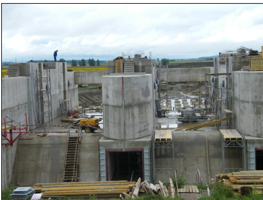
19. ábra. A cigándi tározó beeresztő műtárgya építés közben
