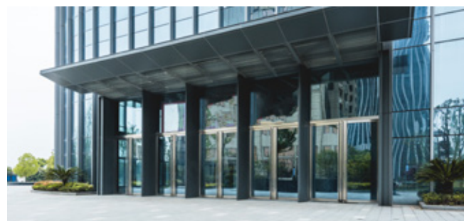
Deur- en gevelbouw
