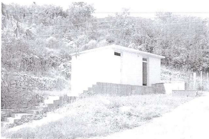
Pumpna stanica Oraška jama – novi pogon
