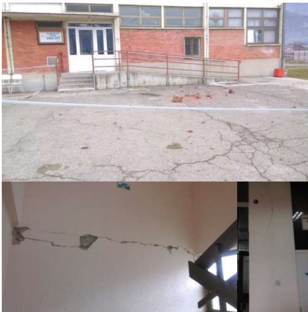
Slika br. 27 Plav 2018. godine, Dom zdravlja "Dr. Branko Zogović": a) Ostaci polomljenog dimnjaka ispred JUDZ, b) Pukotine u nosećem zidu i u uz stepenišni prostor
