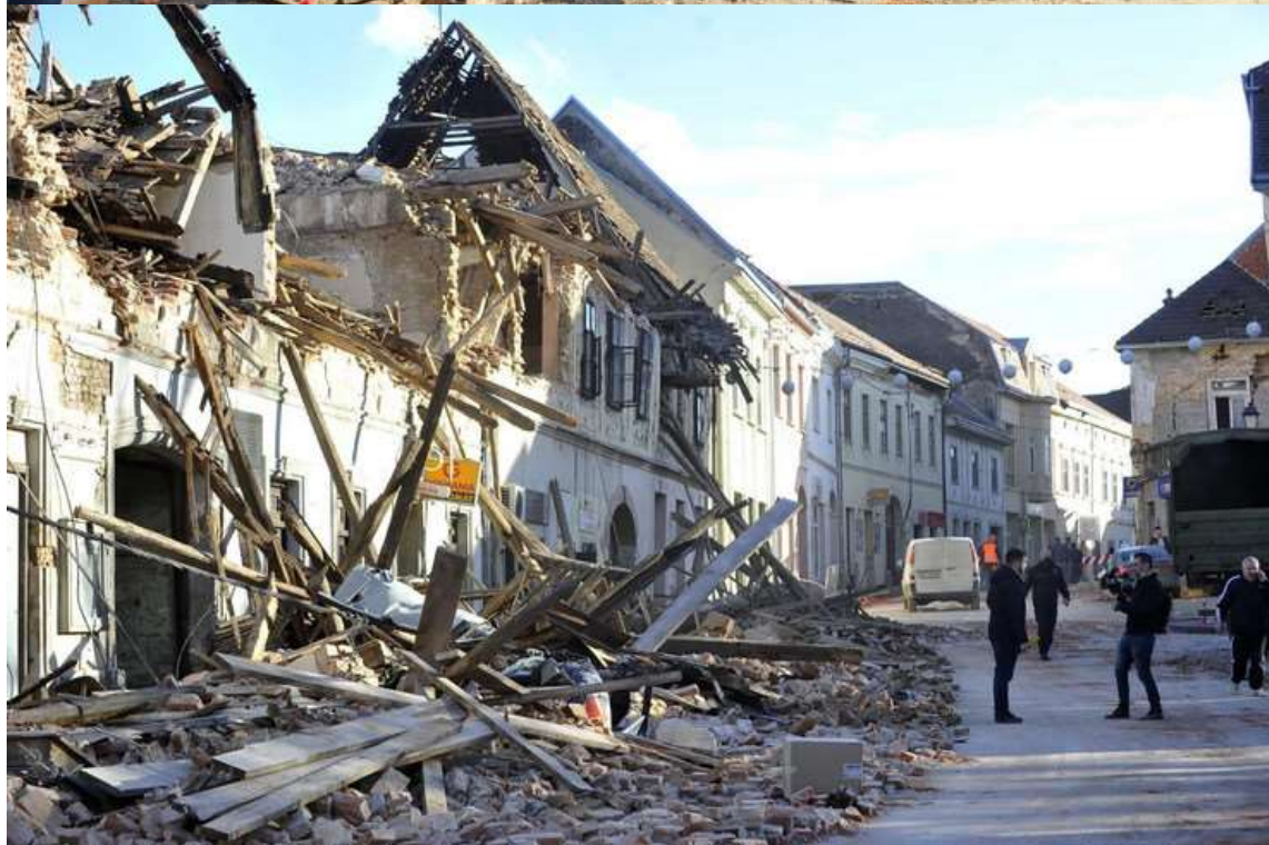
Slika br. 19 Petrinja, 2020. godine: Štete u gradskom bloku tradicionalne gradnje
