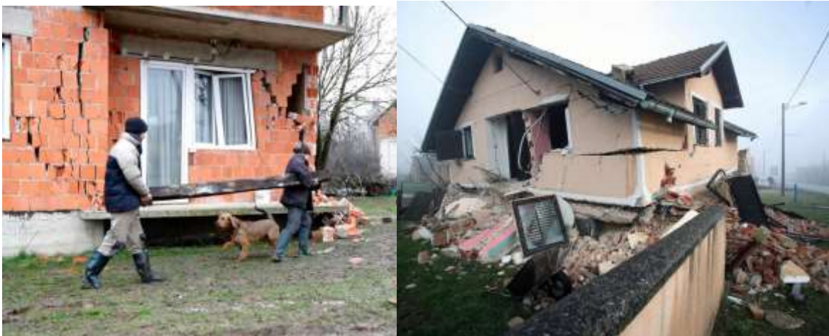
Slika br. 21 Petrinja, 2020. godine: Štete kod individualne gradnje novijeg tipa
