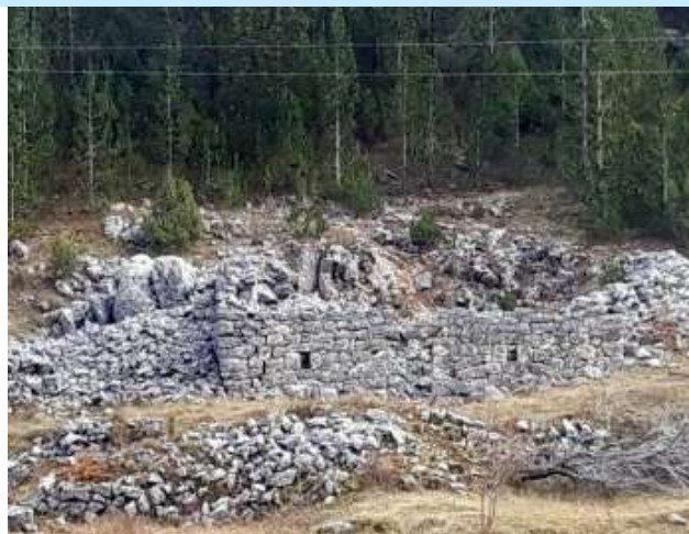
Slika 101. Urušene kamena kuća
