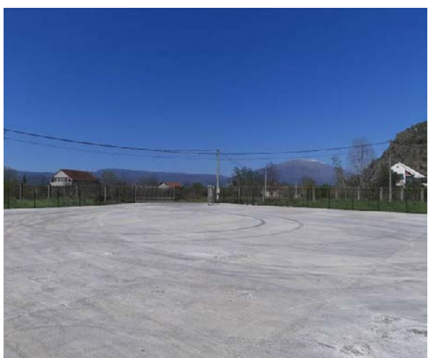
Sl. 2.17. Betonski plato ispred predmetnog objekta
