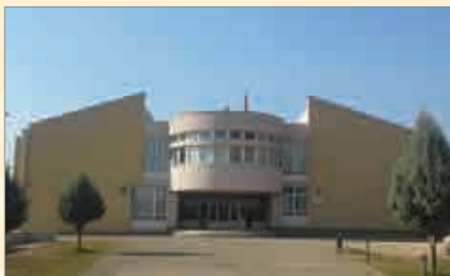
OŠ „Njegoš“ Spuž Novi izgled škole nakon realizacije projekta ES „Njegoš“ Spuž The school appearance following the project implementation
