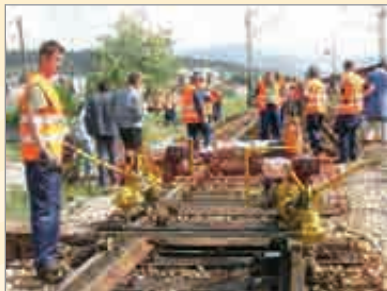
Radovi na rekonstrukciji The reconstruction works
