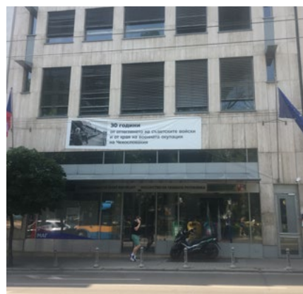
Budova ČC Sofie © Tomáš Starý
