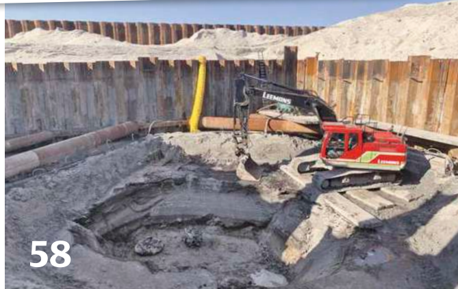
58 Wegen eines neuen Deichs muss das Wrack einer Wellington weichen – dabei kommen erstaunliche Gegenstände zum Vorschein
