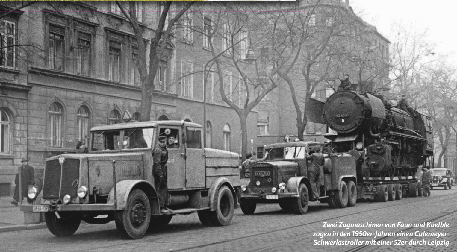
Kibri-HO-Fahrzeuge mit einem Trafo-Transport auf der Autobahn
