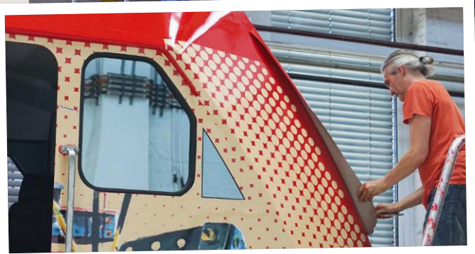
Knifflig wird es nochmal an den Fronten, an denen der Übergang von den Schrägen vollendet wird
