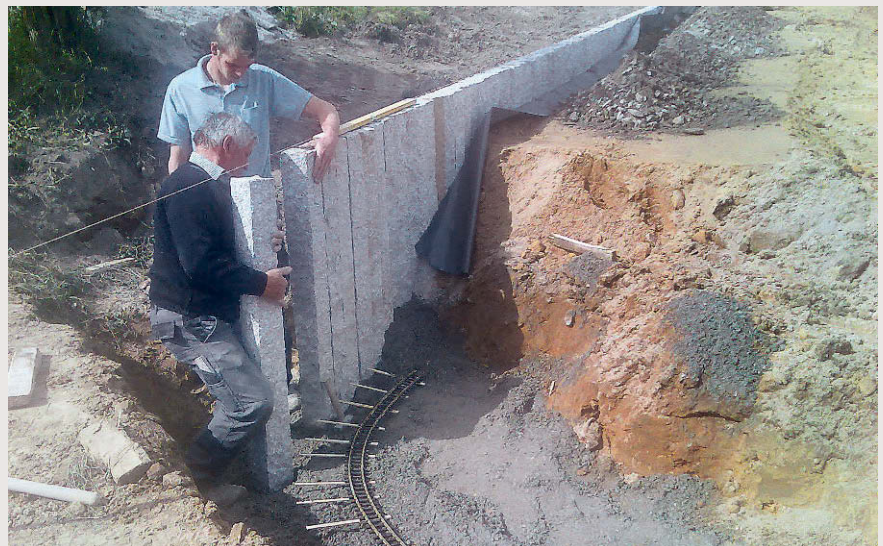
Am Hang musste der zukünftige Bahndamm mit Steinen abgefangen werden
