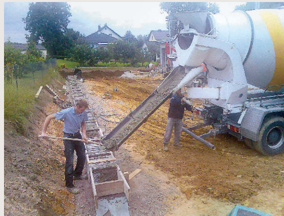
Die Bahntrasse wird aus Beton gegossen. Eine exakte Schalung erleichtert die Arbeiten
