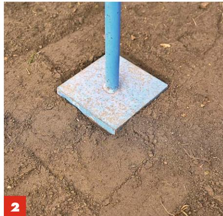
**2** **Verdichten Sie den Boden**. Am einfachsten gelingt das mit einem 12 kg schweren Handstampfer oder einer Rüttelplatte.
