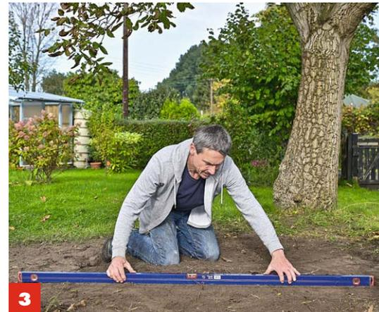
**3** Überprüfen Sie, dass **der Untergrund plan ist**. Falls nicht, verteilen Sie die Erde um und verdichten diese erneut.
