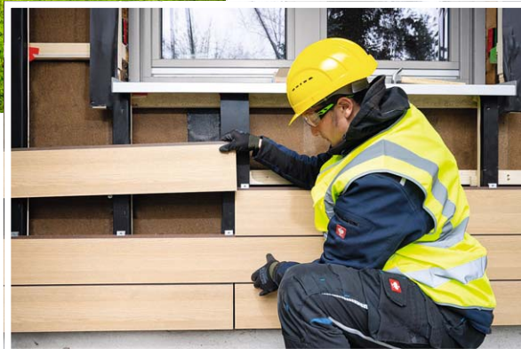
Die Paneele werden auf einer hinterlüfteten Holzkonstruktion an der Fassade angebracht
