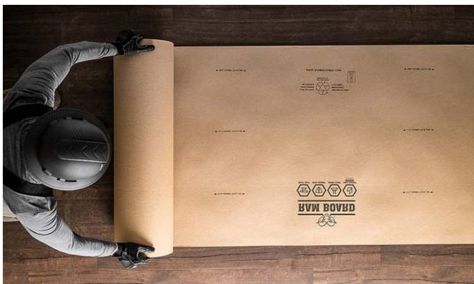
Mit einem Flächen-gewicht von 160 g/m<sup>2</sup> und 1 m Rollenbreite ist dieses Vlies besonders zum Abdecken größerer Flächen geeignet
