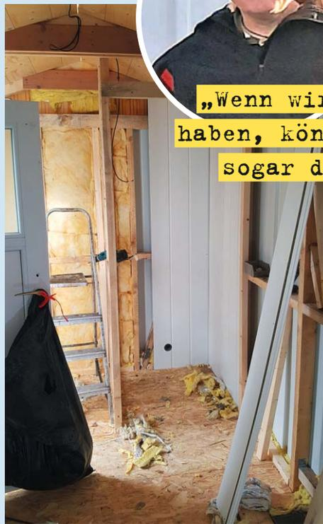
Für angenehme Wärme dämmen die Selbermacher Wände, Dach und Boden **mit Steinwolle**
